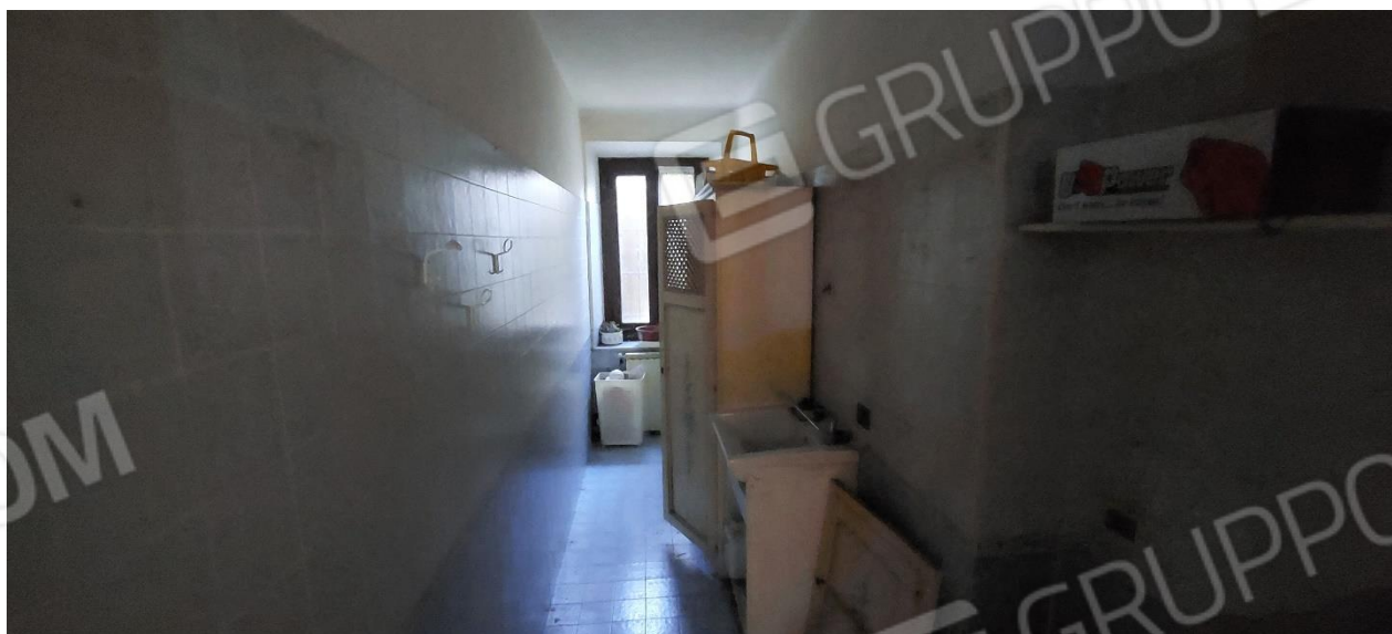
FOTO 13 – Bagno piano terreno
