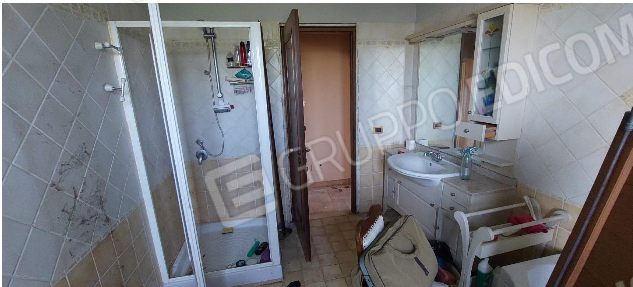
FOTO 18 – Bagno piano primo
