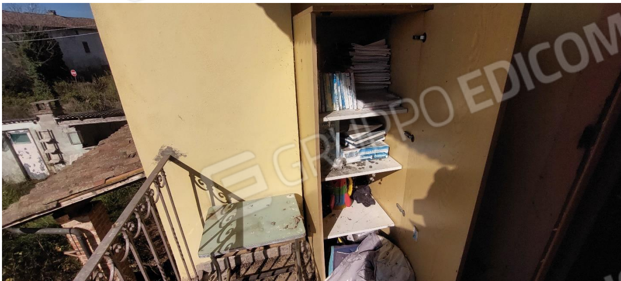
FOTO 24 – Terrazzo piano primo
