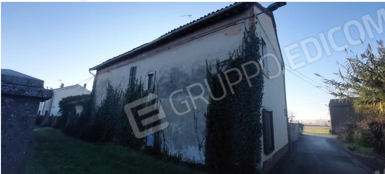
FOTO 3 – Prospetto lato nord
