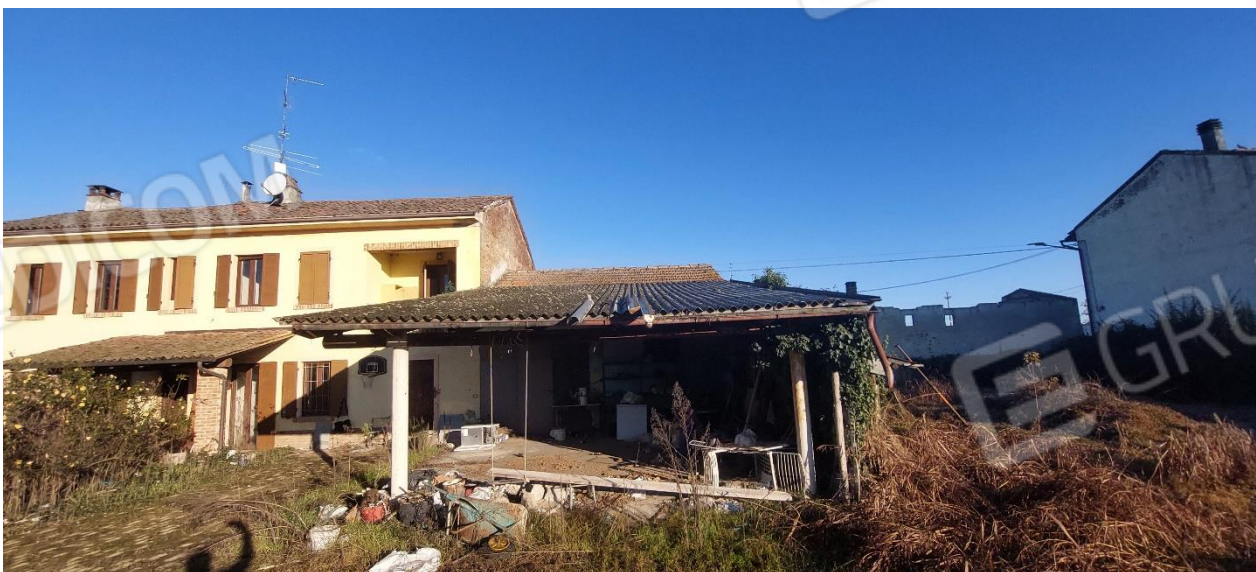
FOTO 5 – Porticato aperto lato sud
