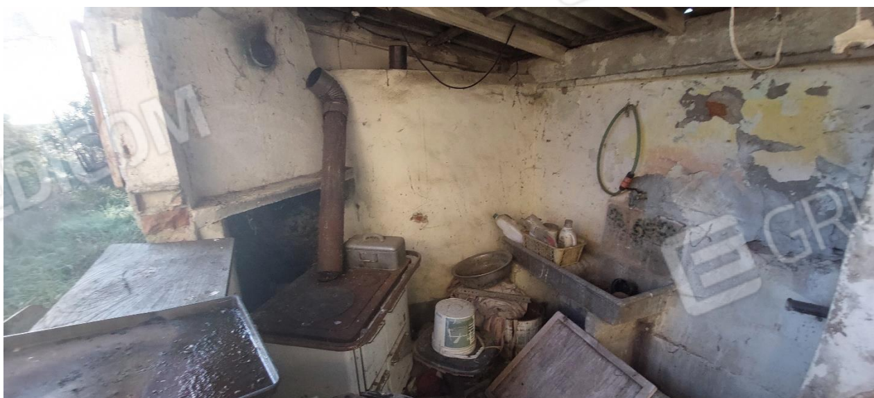
FOTO 37- Ripostiglio basso fabbricato accessorio
