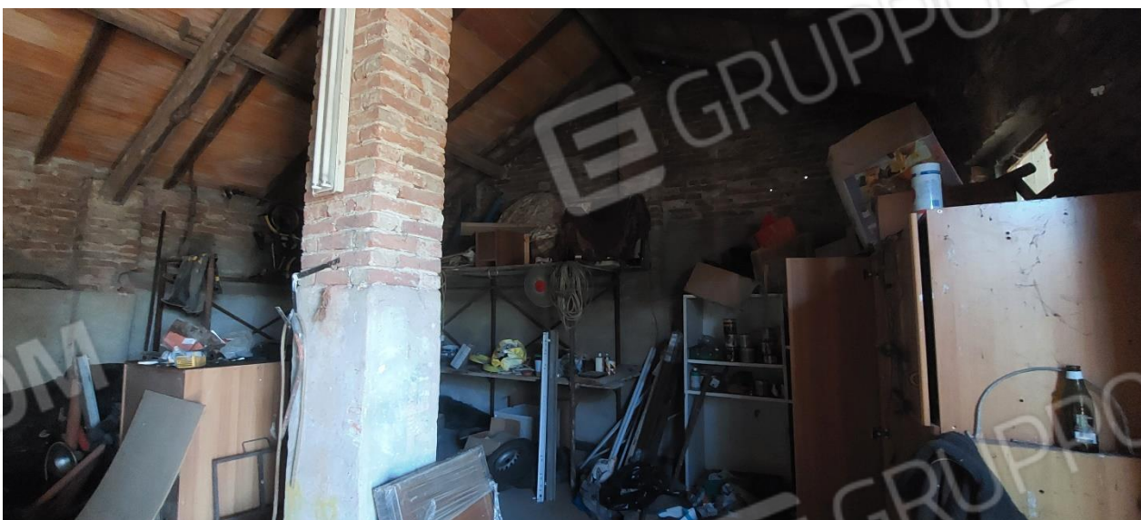
FOTO 33 – Magazzino piano terreno
