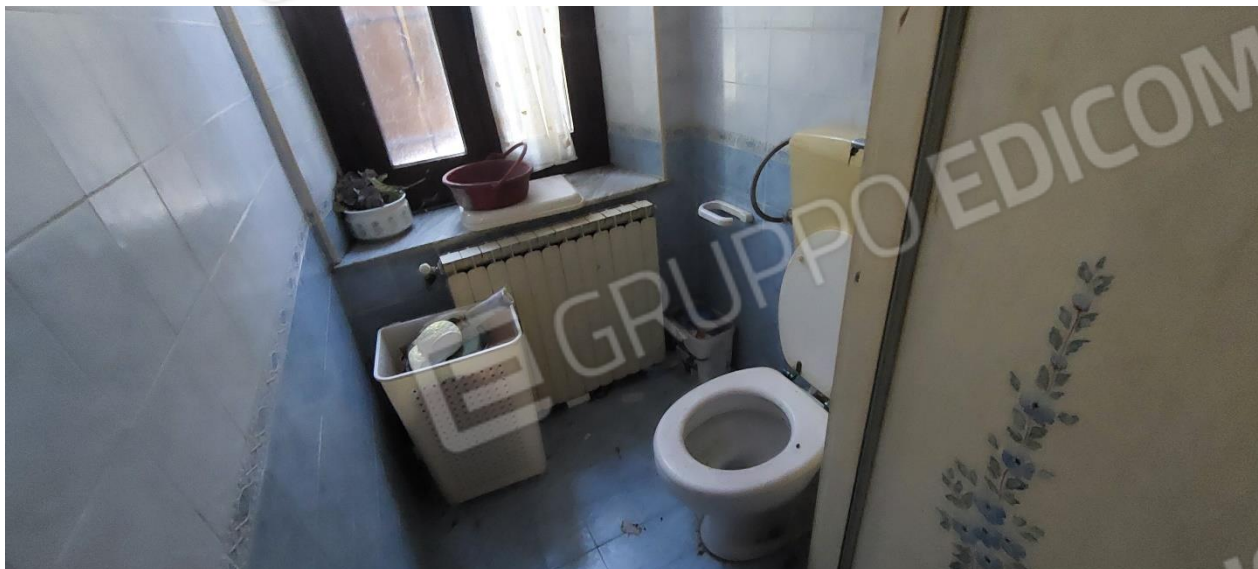
FOTO 12 – Bagno piano terreno
