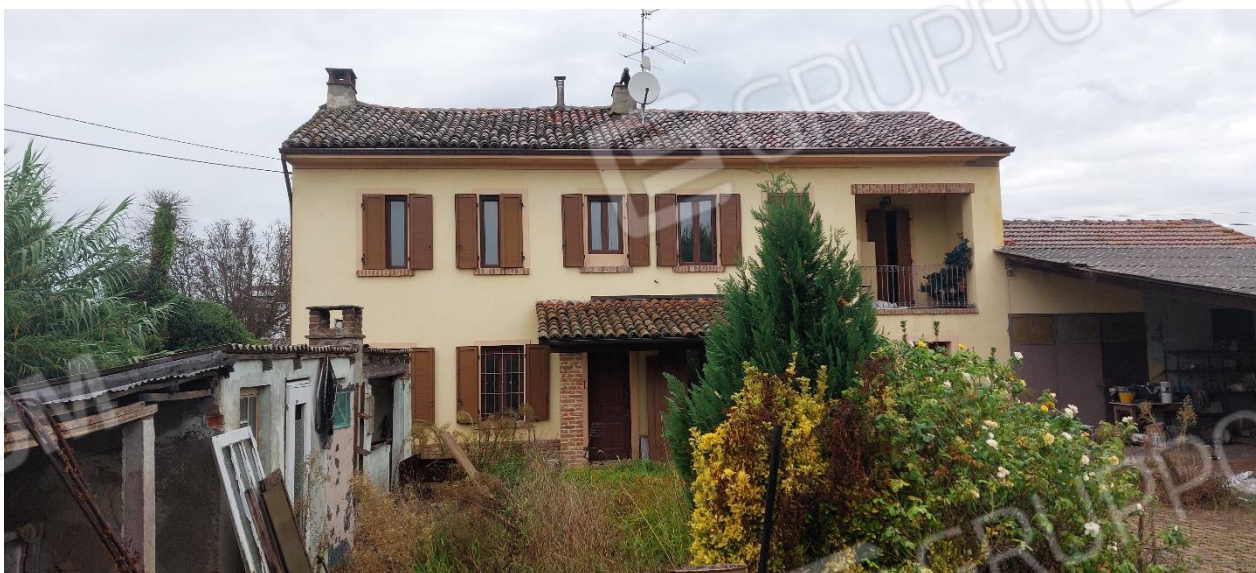
FOTO 4 – Prospetto lato sud nel cortile di proprietà
