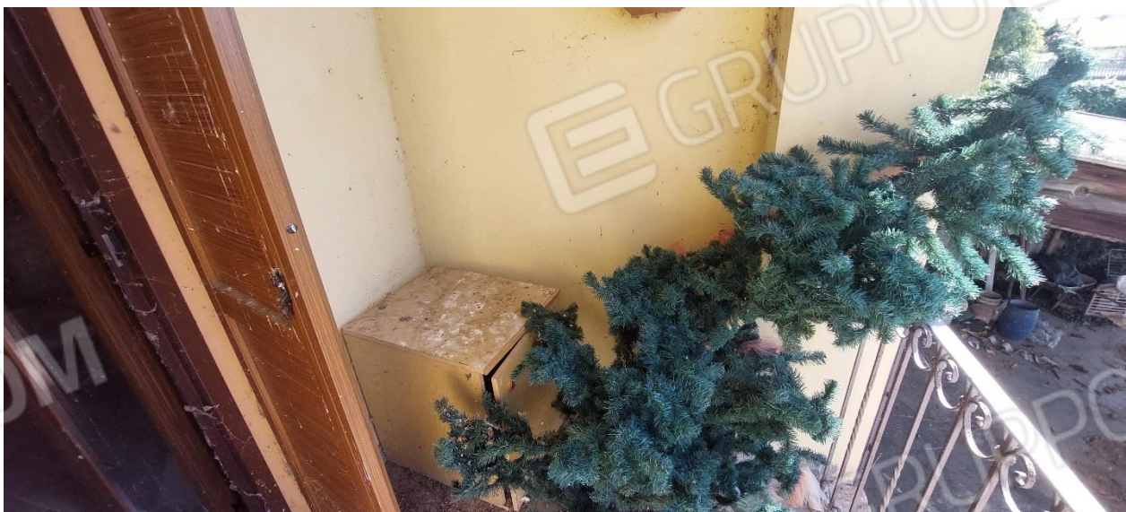
FOTO 25 – Terrazzo piano primo
