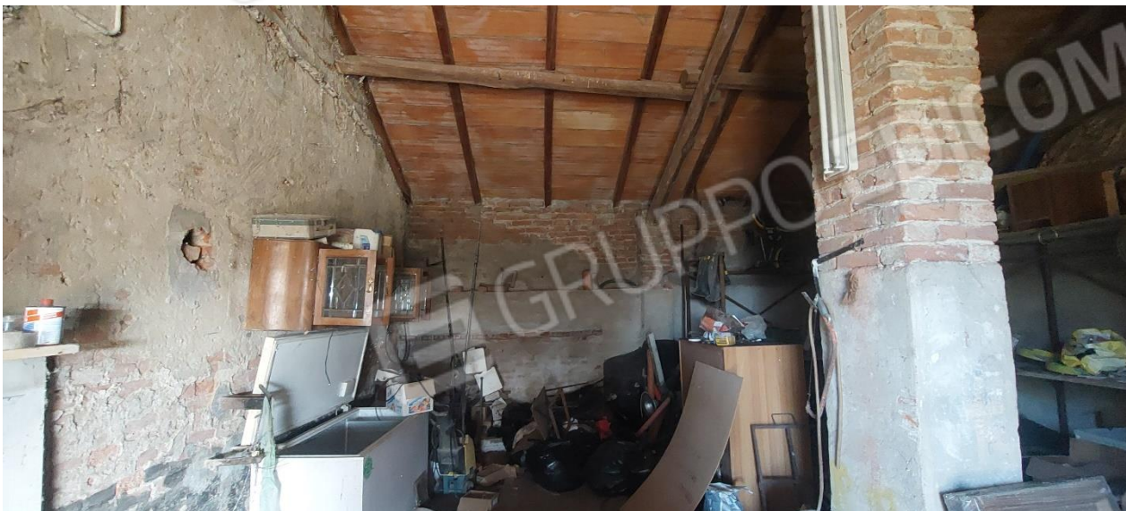
FOTO 32 – Magazzino piano terreno
