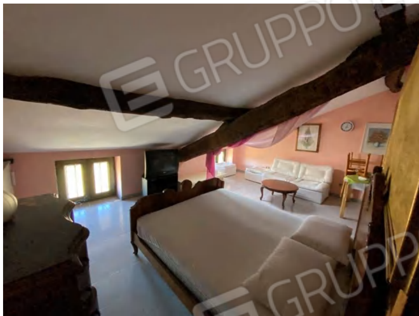
CUCINA/CAMERA (SUB. 8) soffitto
