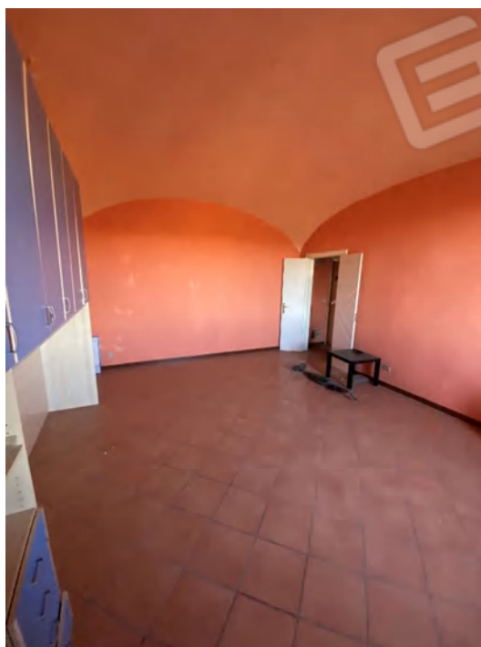
CAMERA "A,, (SUB. 5) pavimento e soffitto
