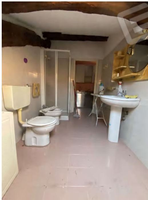
BAGNO (SUB. 8) pavimento, rivestimento e soffitto
