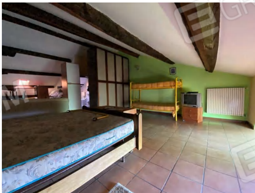
CUCINA/CAMERA (SUB 10) pavimento e soffitto
