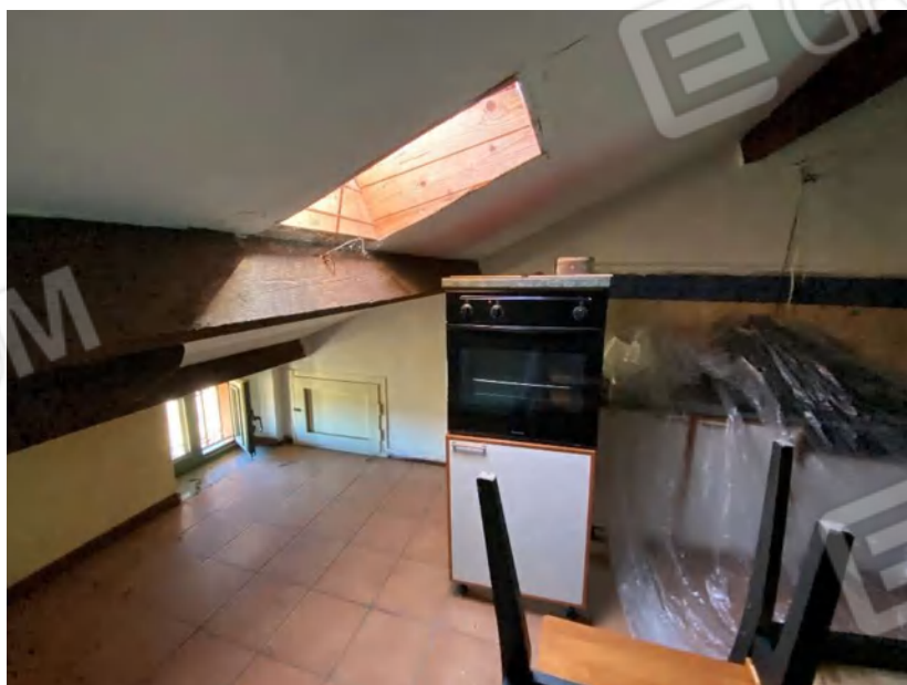
CUCINA/CAMERA (SUB 10) pavimento e soffitto
