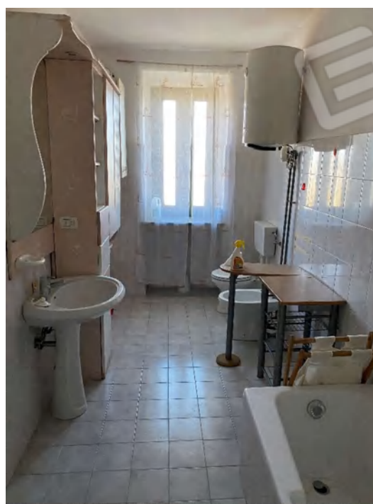
BAGNO (SUB 6) pavimento e rivestimento
