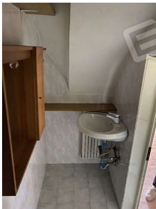
BAGNO (B) (SUB. 5) soffitto
