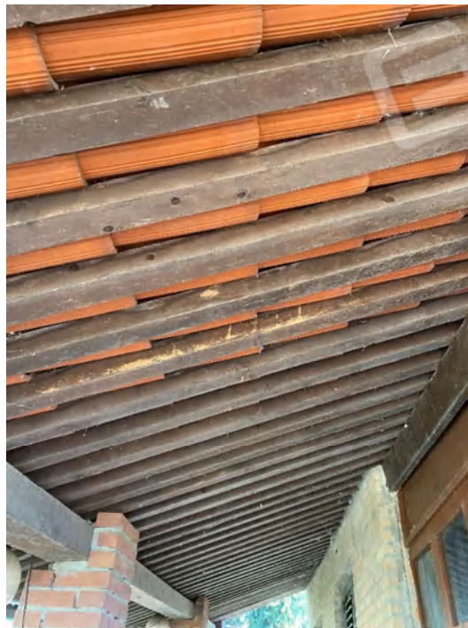
PORTICATO manto di copertura
