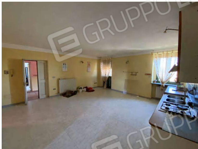
CUCINA/SOGGIORNO (SUB 6) soffitto
