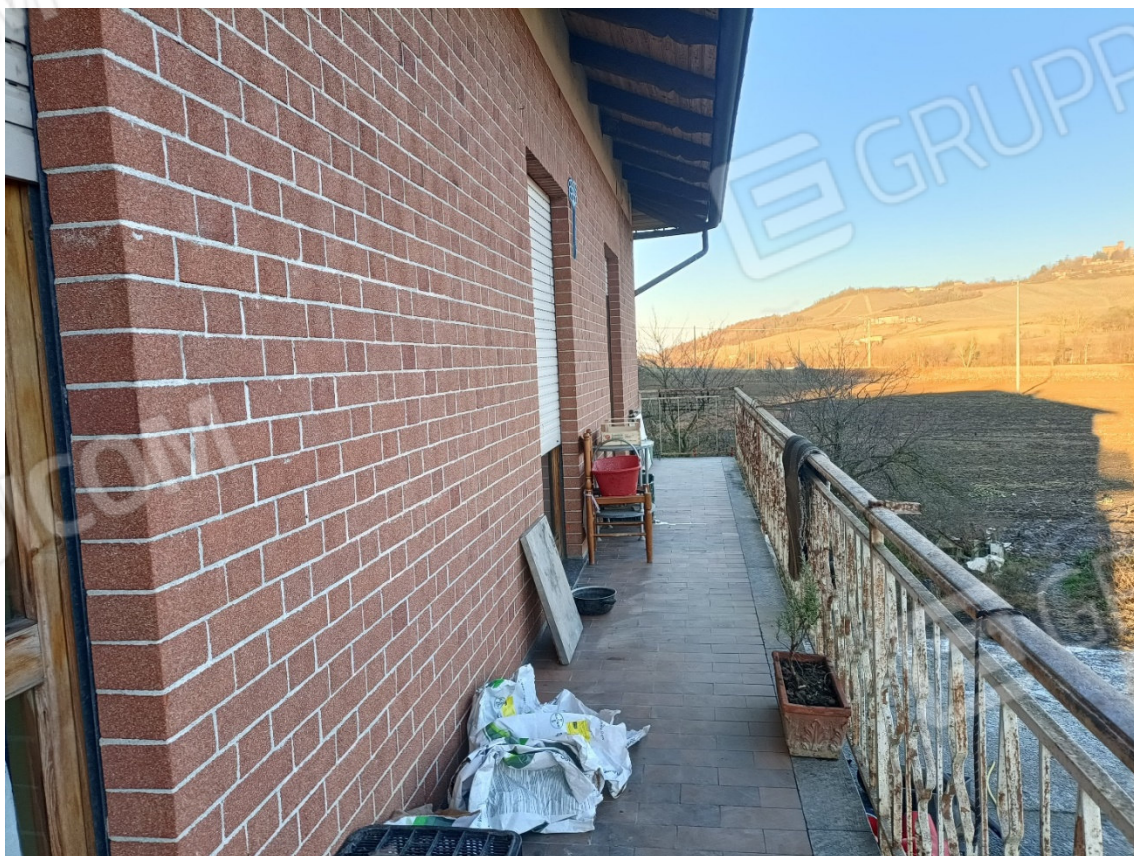
30-Abitazione: balcone prospetto sud-est
