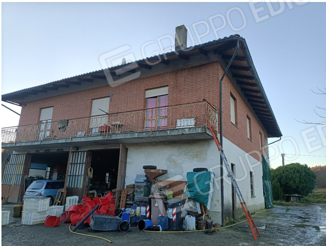
3-Fabbricato residenziale prospetto sud-est e nord-est
