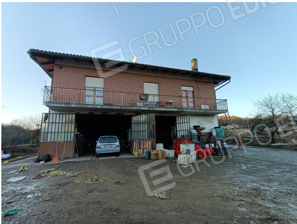
1-Fabbricato residenziale prospetto sud-est
