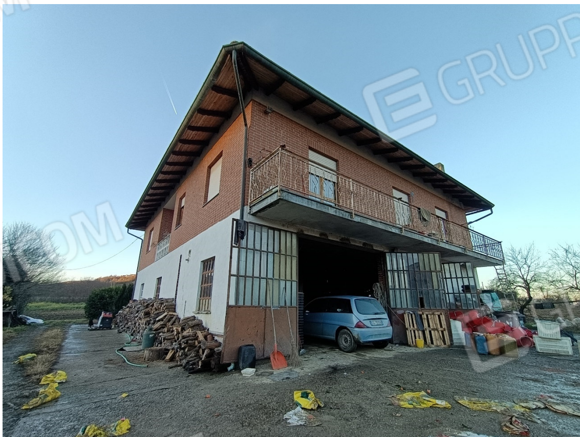
4-Fabbricato residenziale prospetto sud-est e sud-ovest
