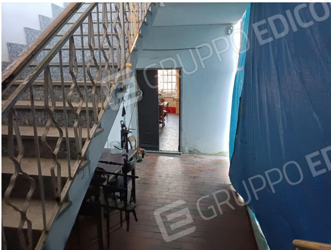
5-Fabbricato residenziale: vano scala esterno
