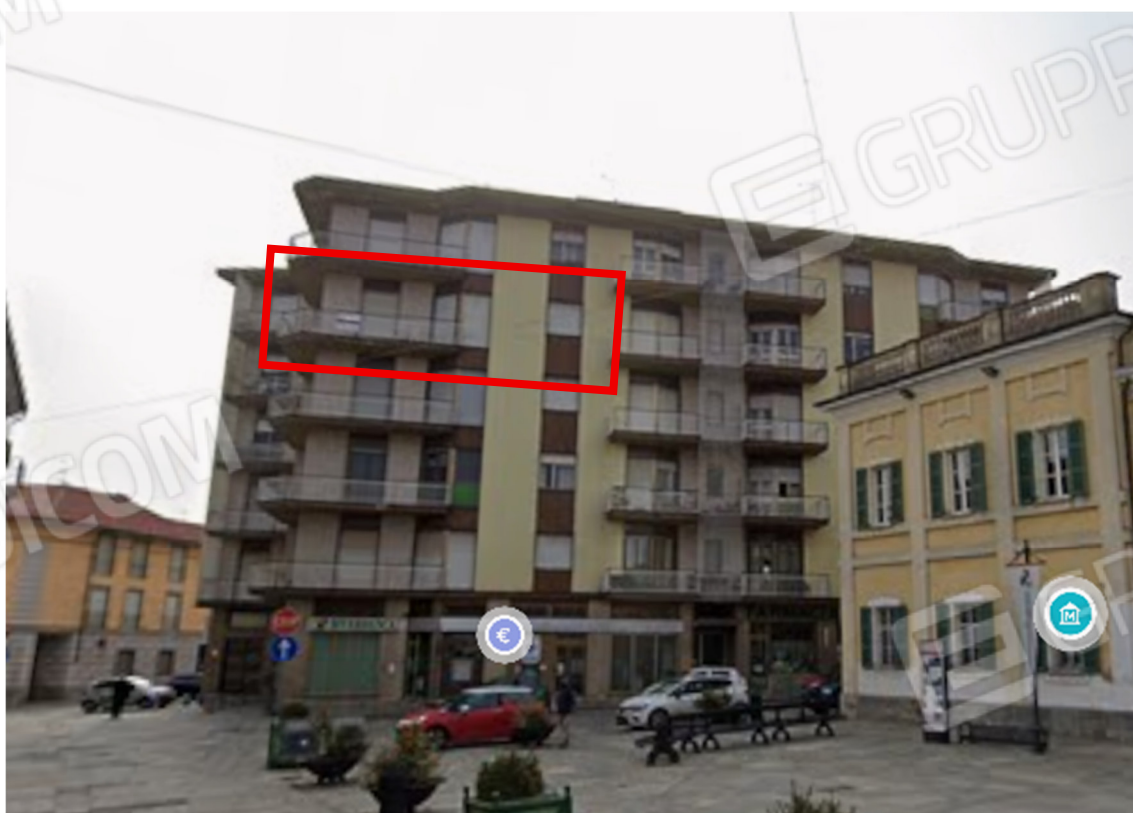
2-Prospetto nord su Piazza G. Ferraris prima dei lavori in facciata
