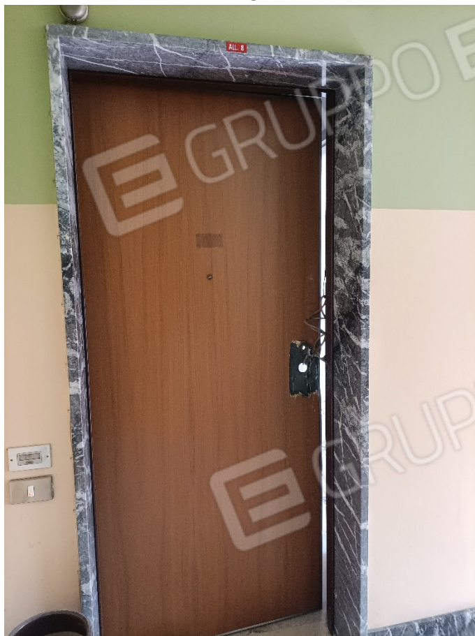
4- Porta di ingresso su vano scala comune
