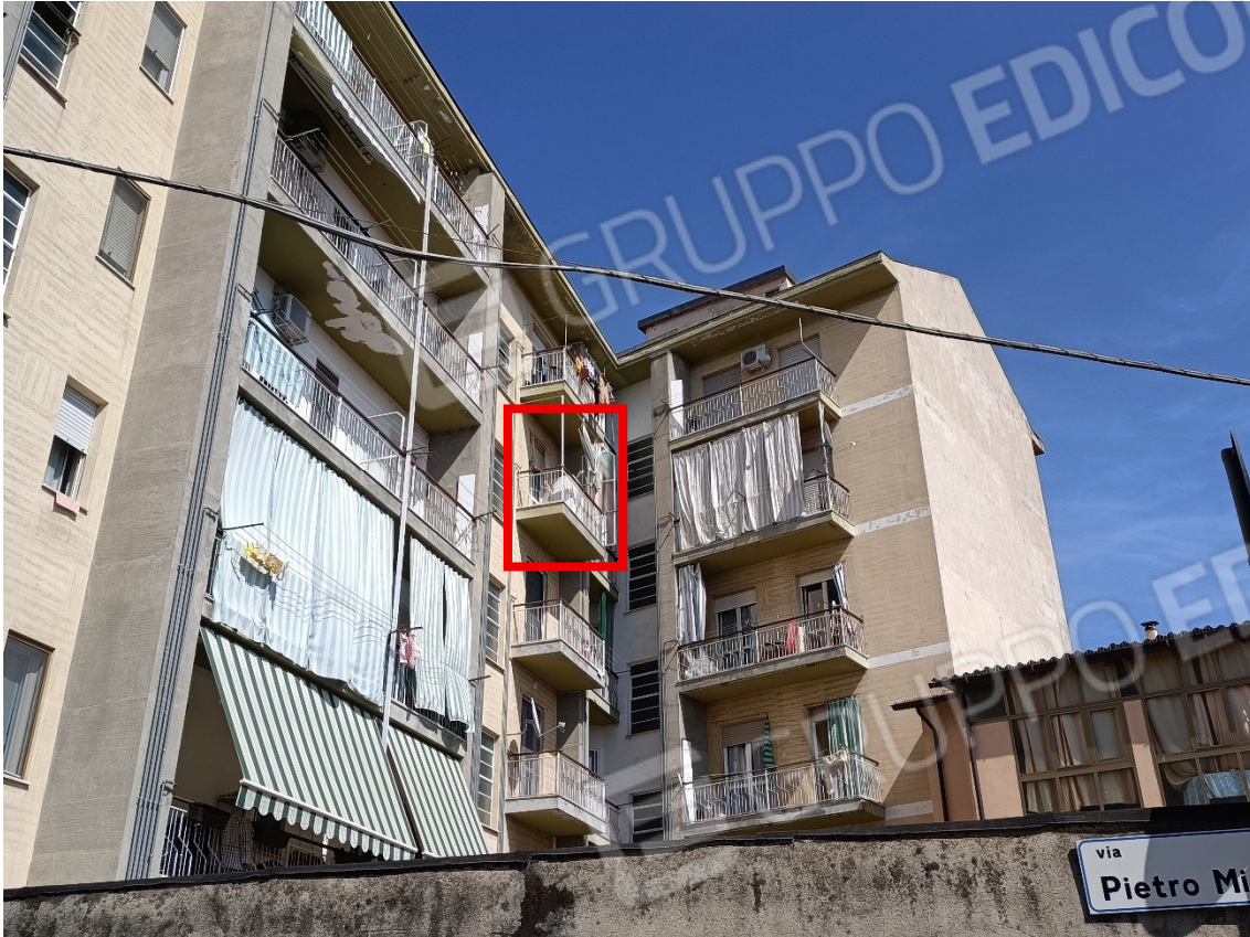
3- Prospetto sud su cortile interno
