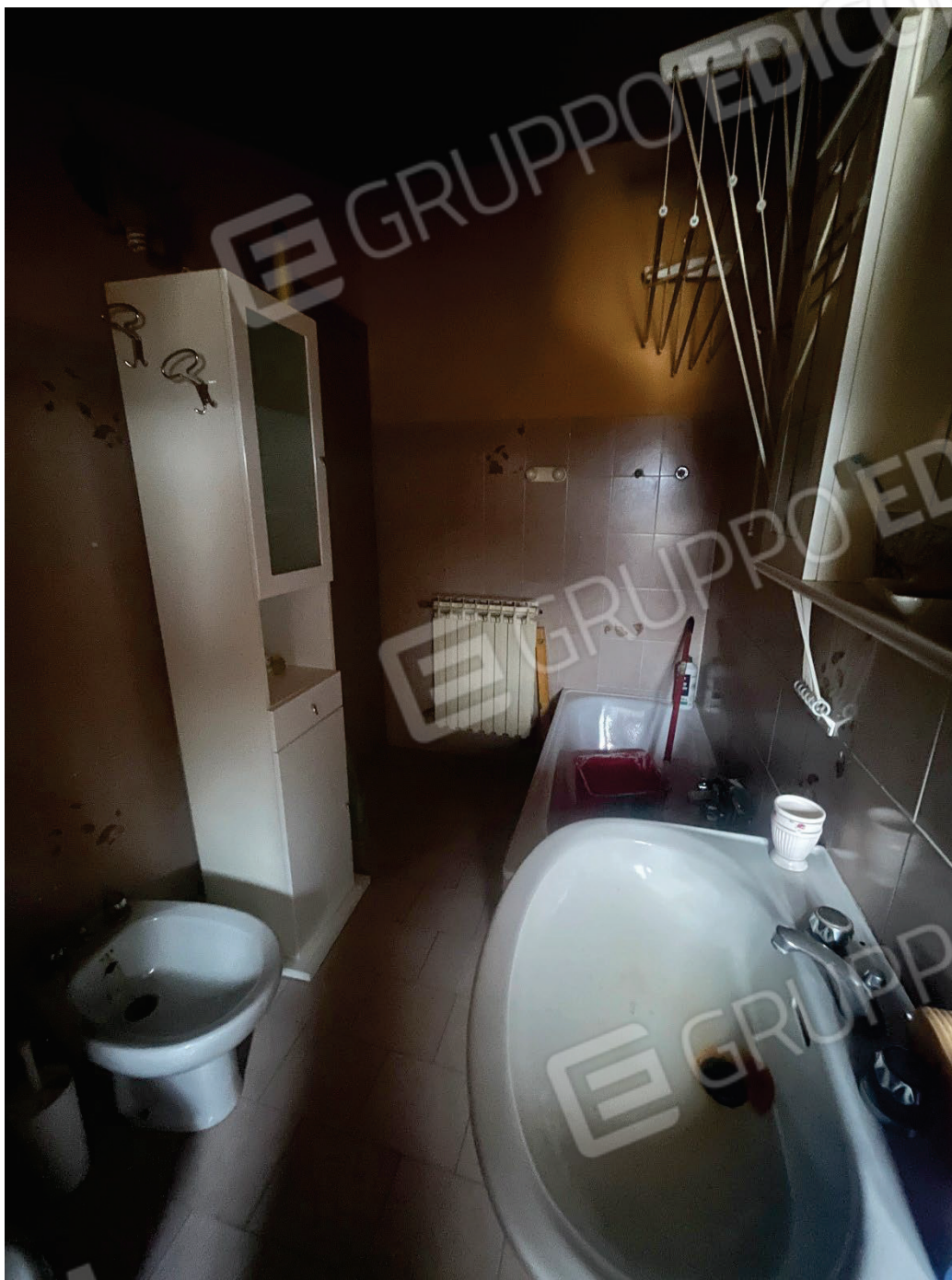
Figura 20: vista del vano adibito a bagno
