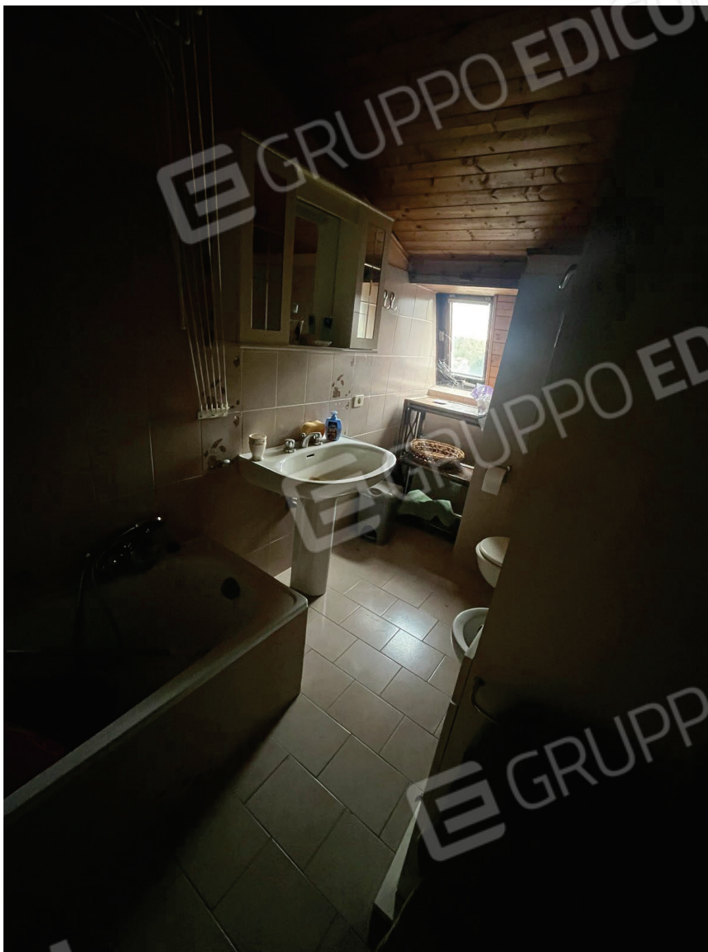
Figura 19: vista del vano adibito a bagno
