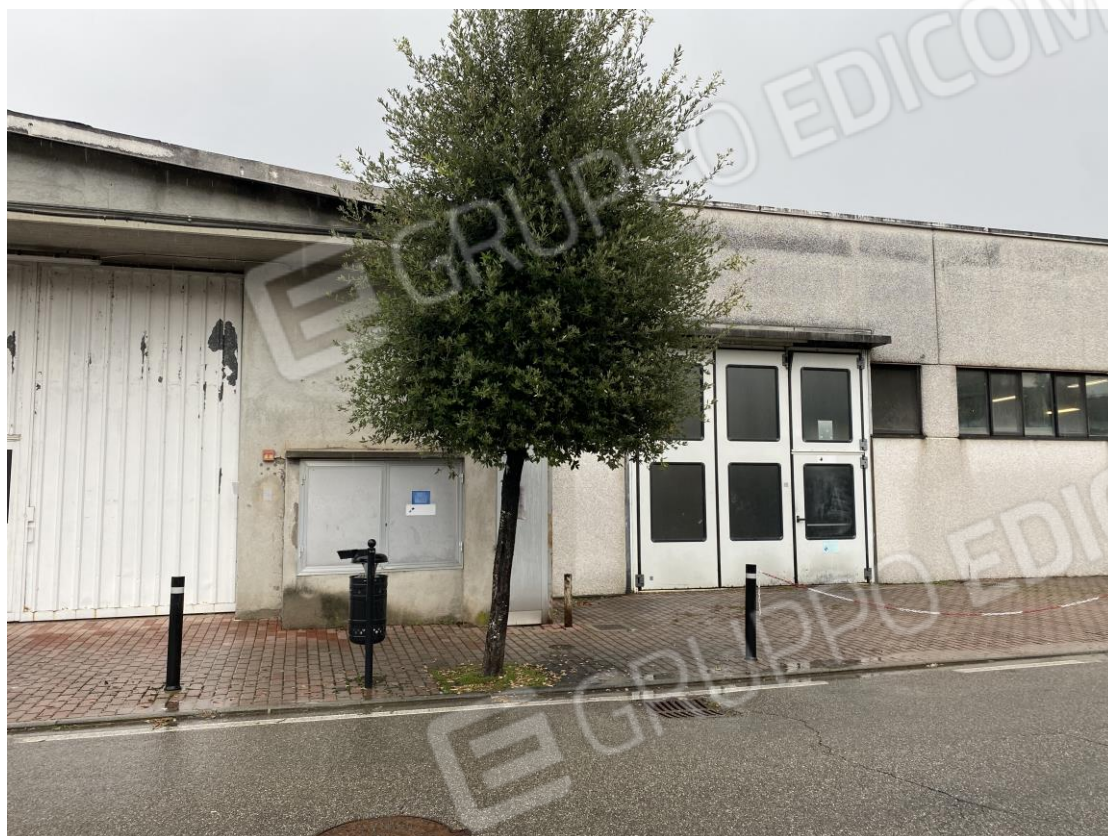
VIALE SANT'EUSEO - A SINISTRA CAPANNONE ORIGINARIO, A DESTRA AMPLIAMENTO
