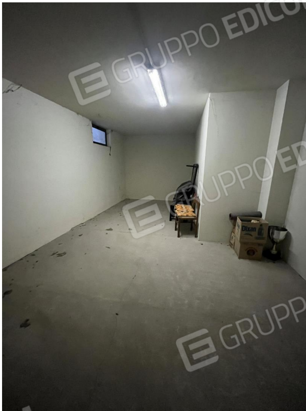
Figura 23: vista della cantina del bene 1
