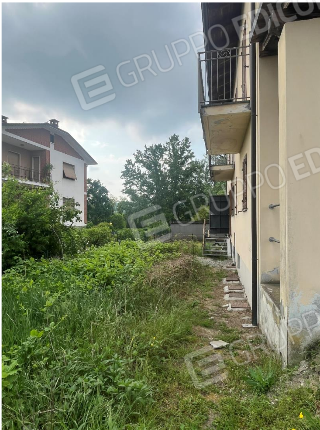
Figura 14: vista del cortile esclusivo del bene 1
