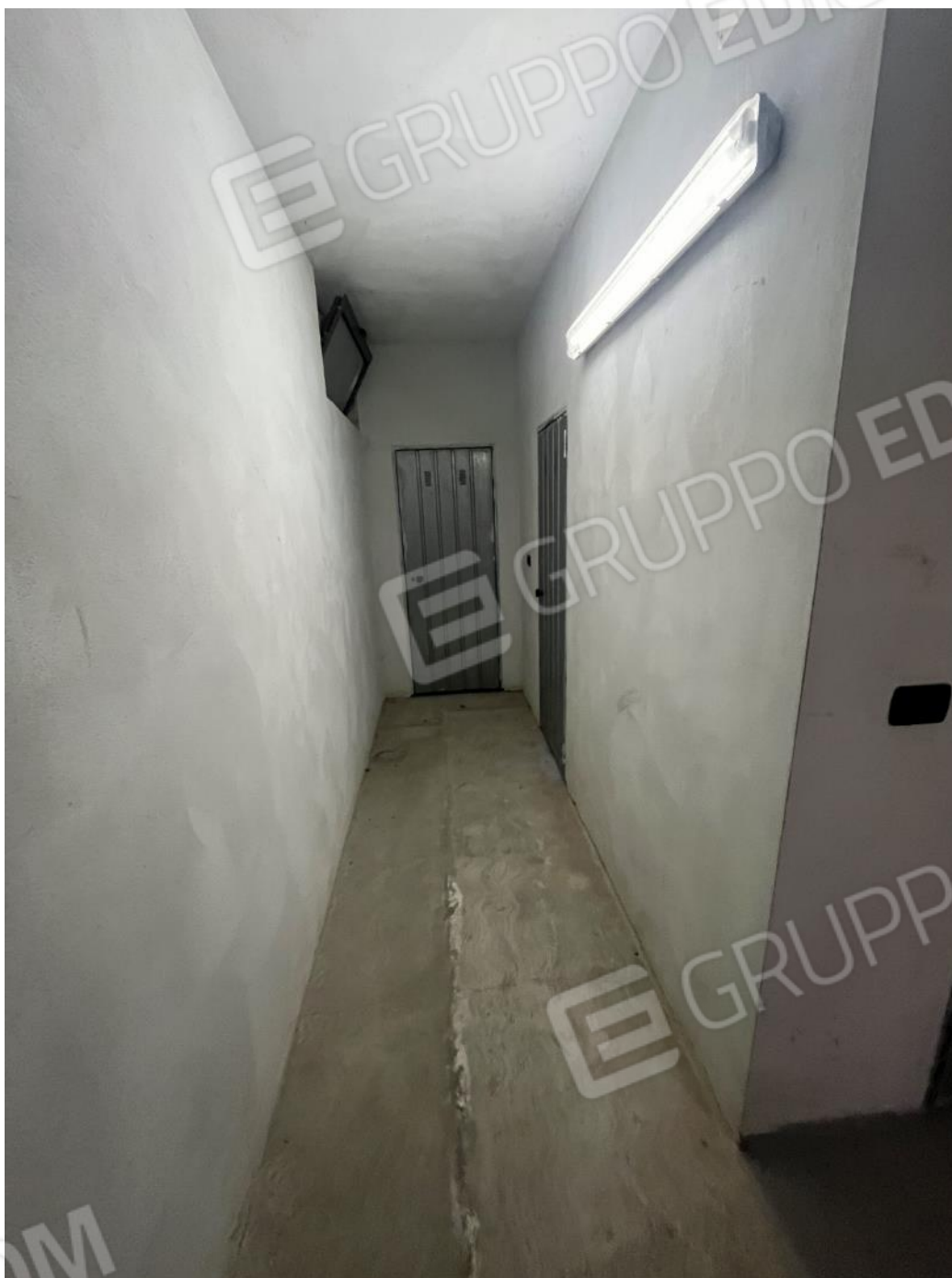
Figura 22: vista del corridoio comune di accesso alla cantina del bene 1
