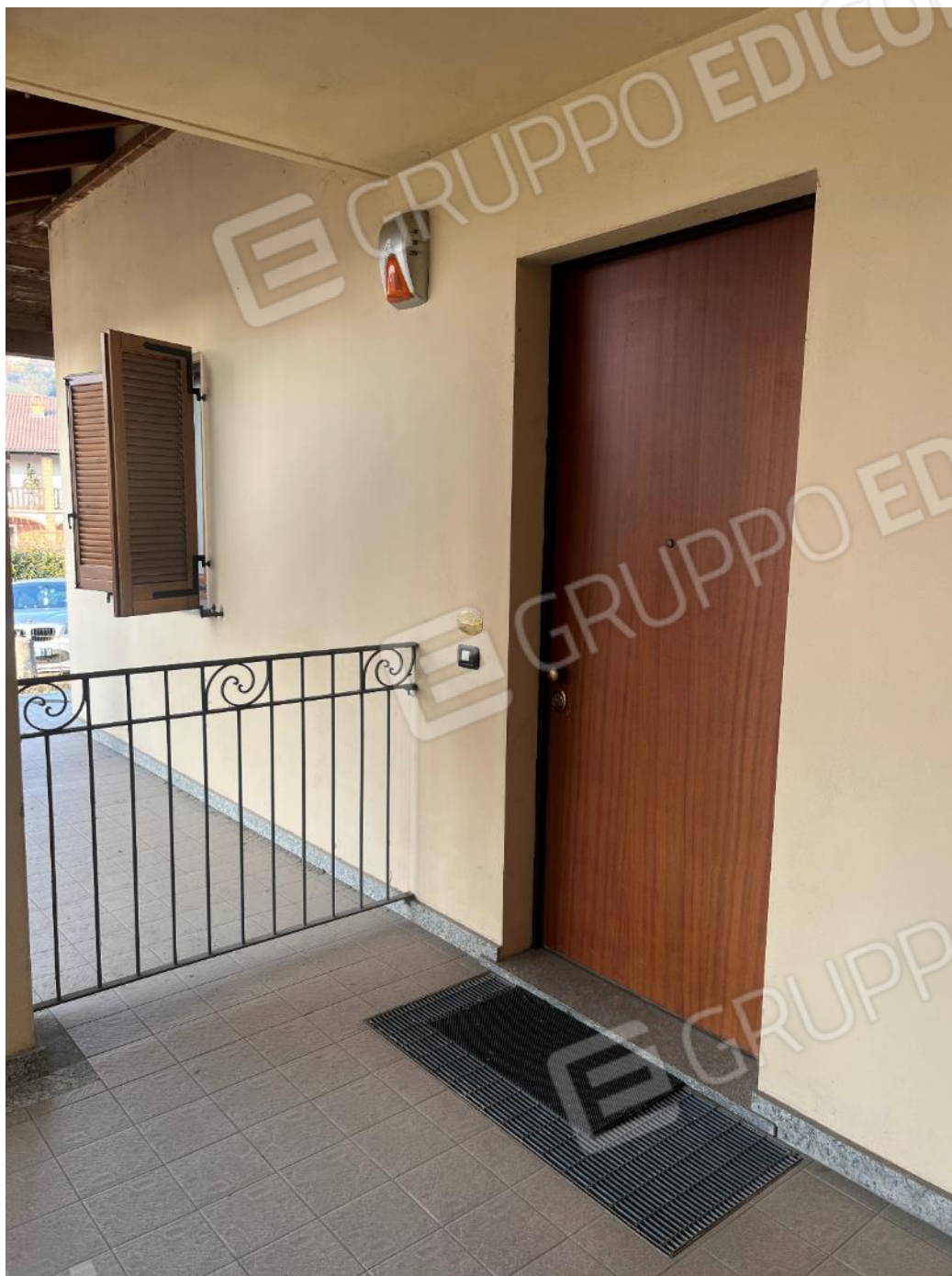
Figura 15: vista dell'ingresso del bene 1
