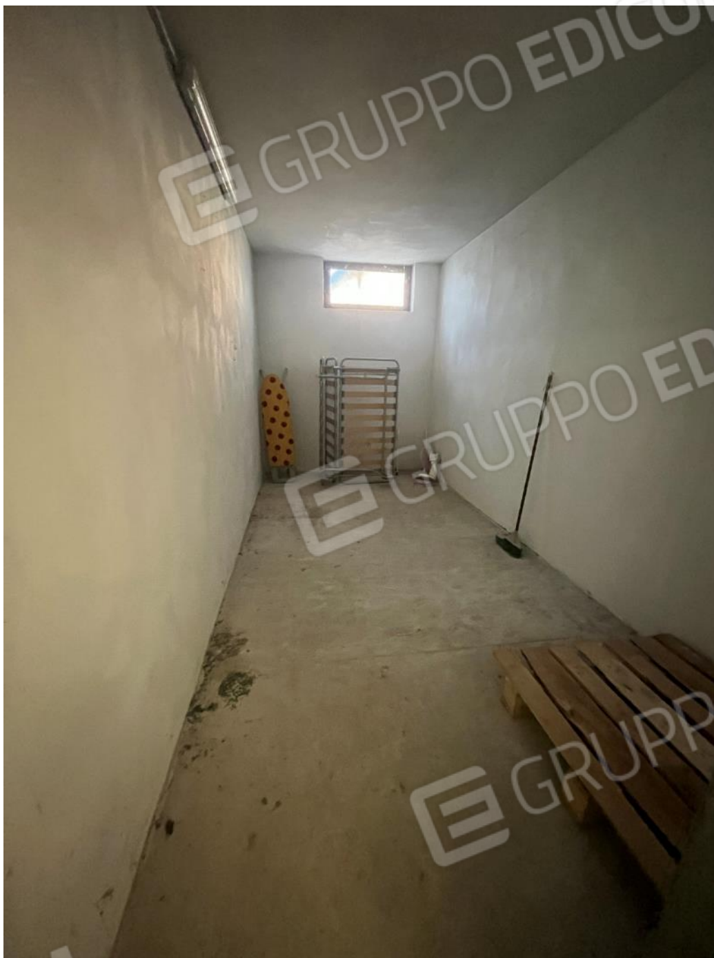
Figura 33: vista della cantina del bene 2
