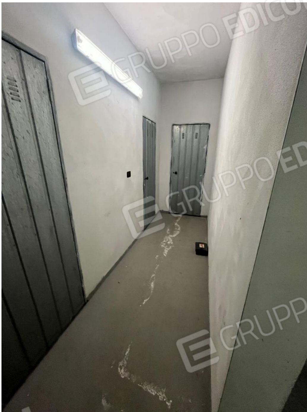
Figura 32: vista del corridoio comune di accesso alla cantina del bene 2
