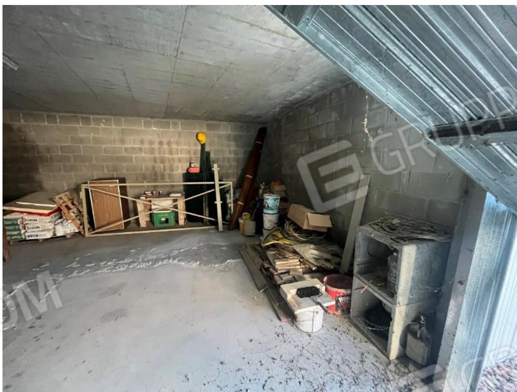
Figura 45: vista dell'interno del bene 5
