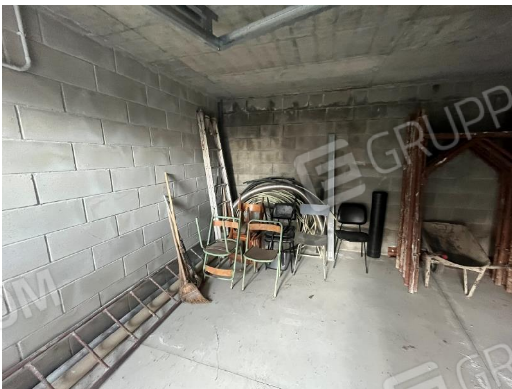
Figura 47: vista dell'interno del bene 5
