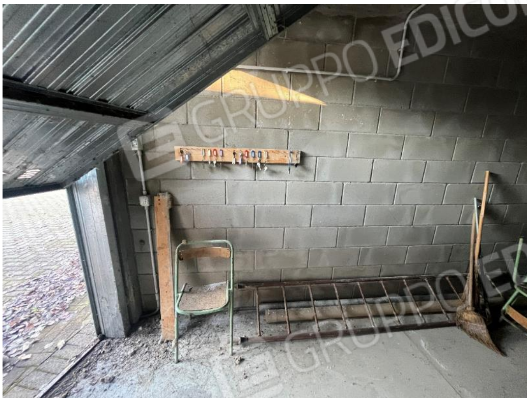
Figura 44: vista dell'interno del bene 5
