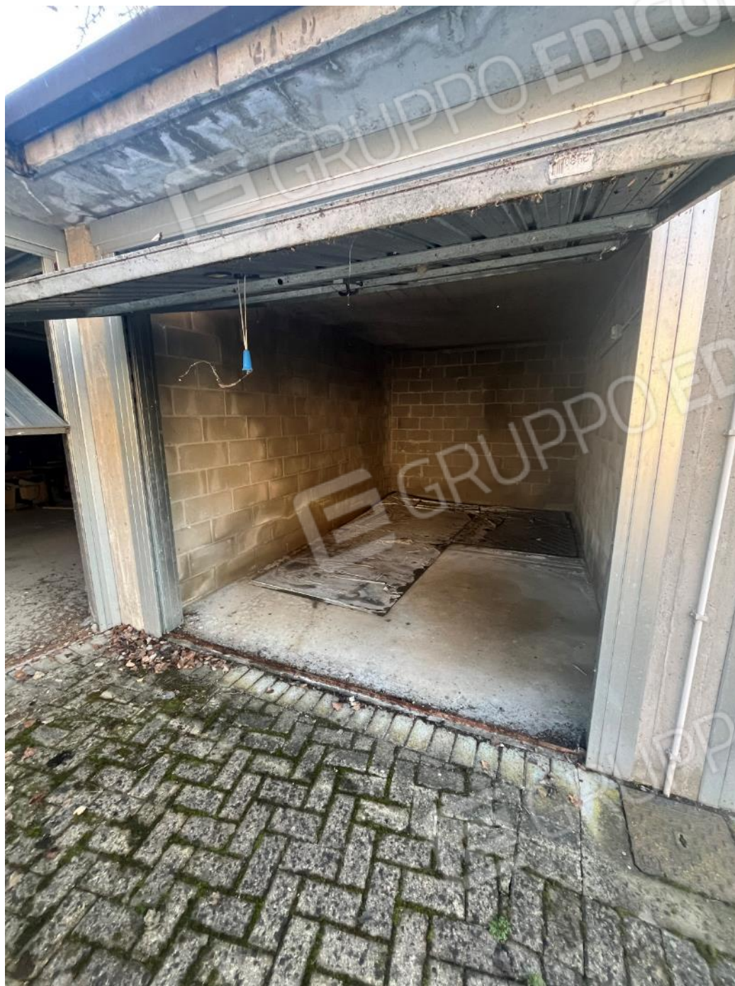
Figura 48: vista dell'interno del bene 6
