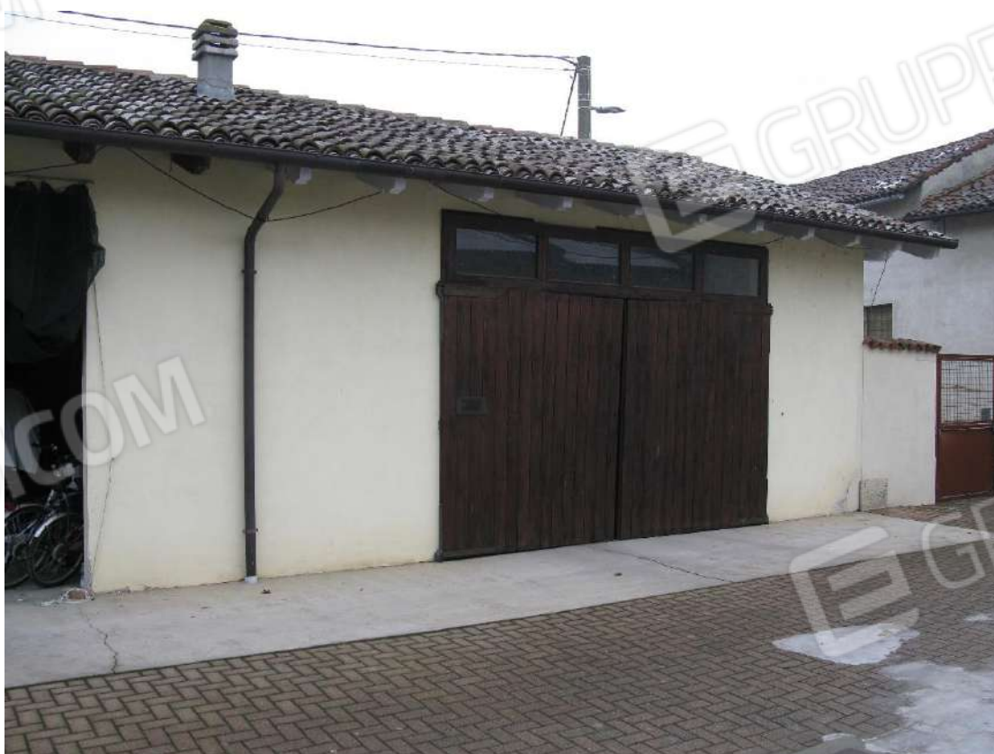
Foto 54 – Garage al piano terreno – Bene 5
