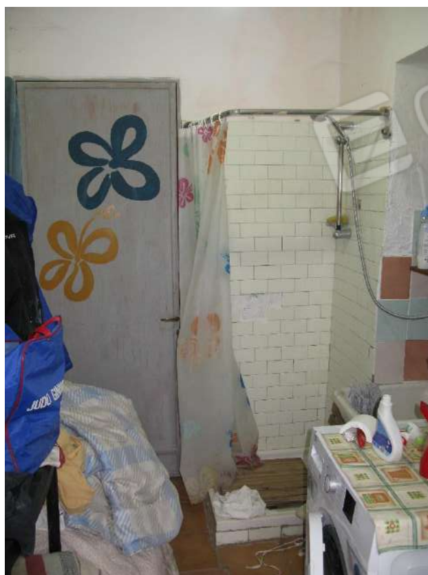
Foto 36 – Lavanderia al piano terreno – Bene 3
