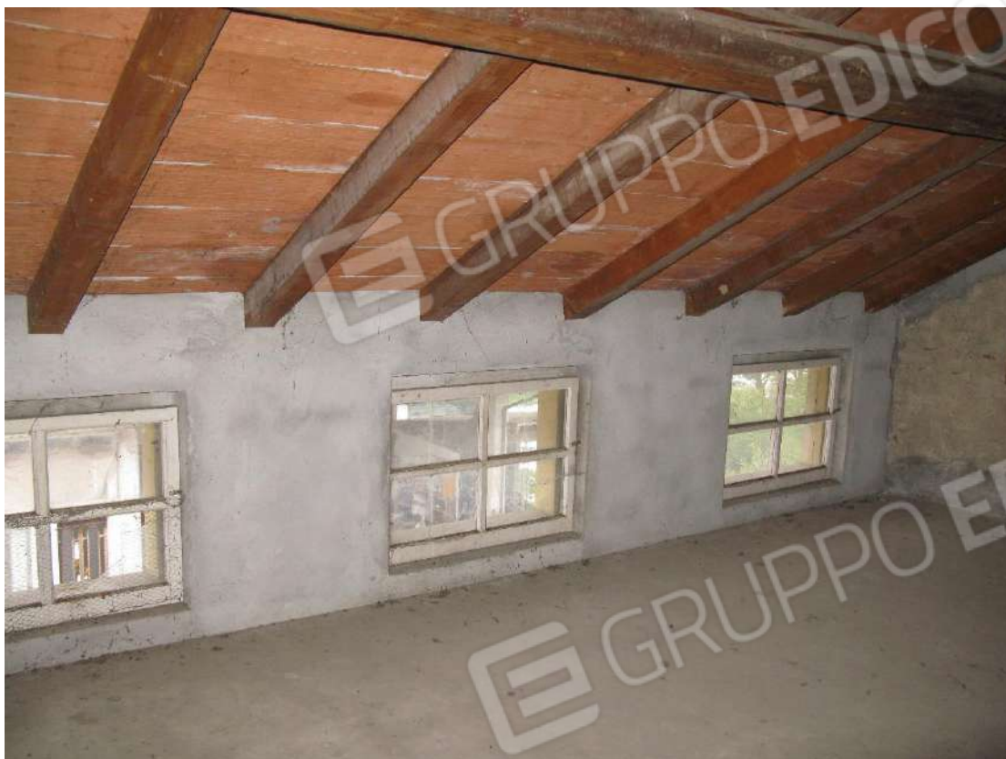
Foto 33 – Soffitta al piano secondo – Bene 2
