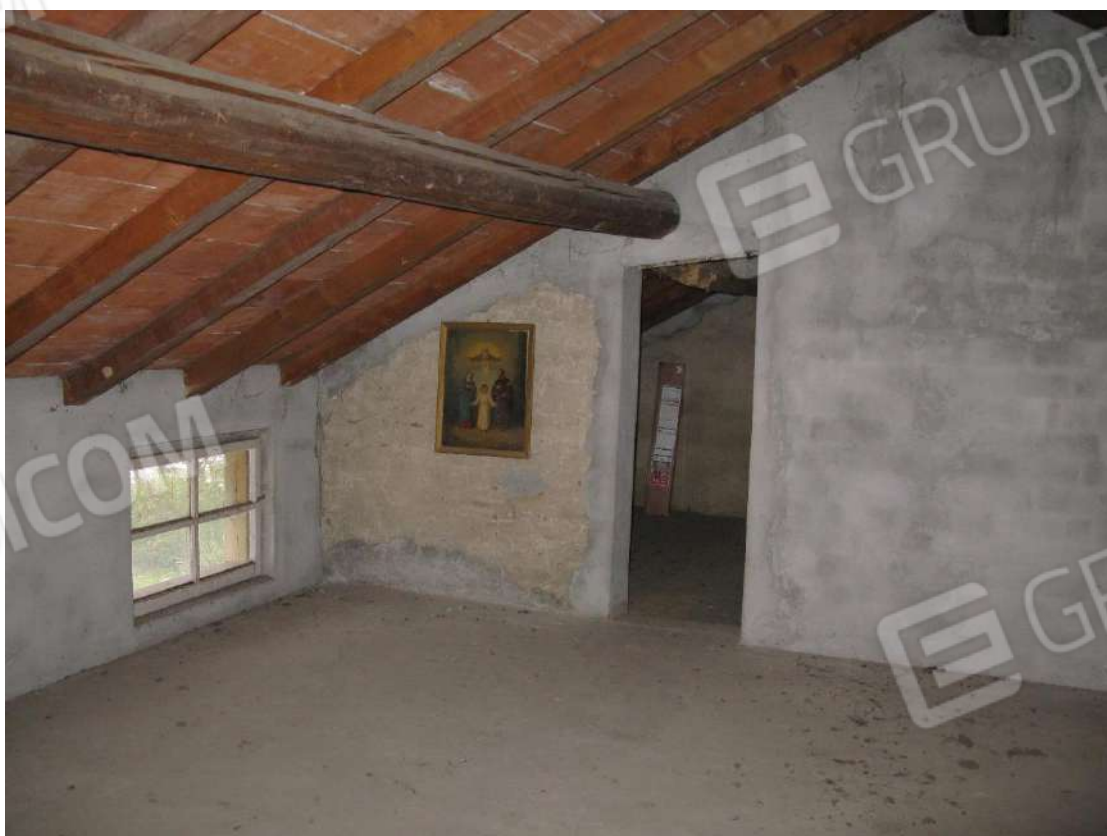
Foto 32 – Soffitta al piano secondo – Bene 2
