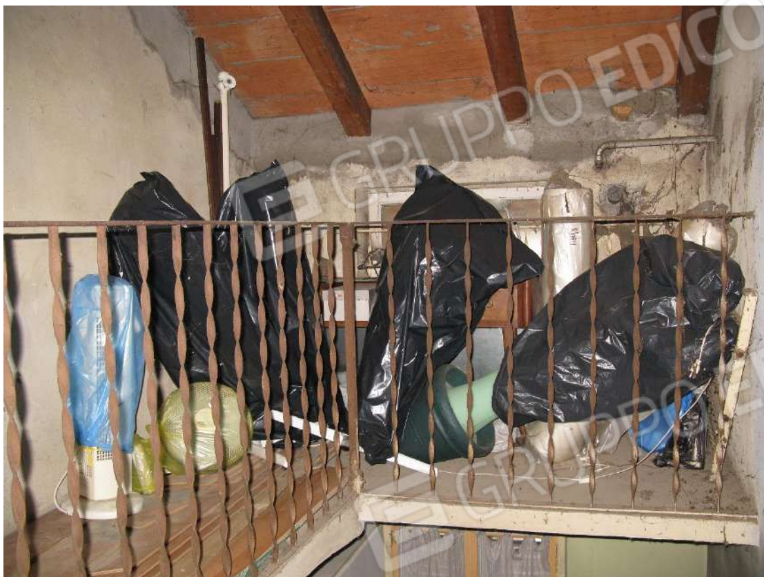
Foto 29 – Soffitta al piano secondo – Bene 2
