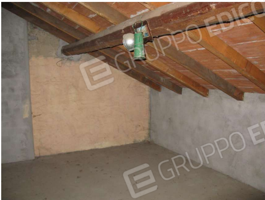
Foto 31 – Soffitta al piano secondo – Bene 2
