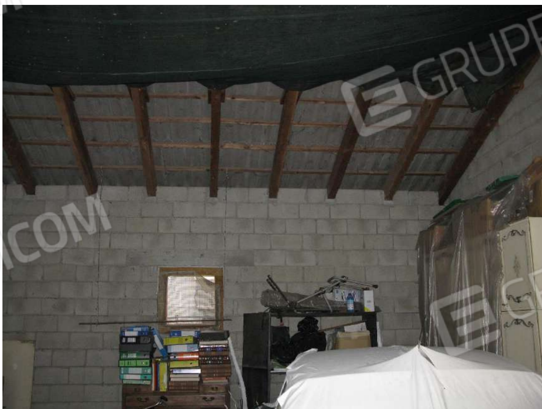
Foto 56 – Garage al piano terreno – Bene 5
