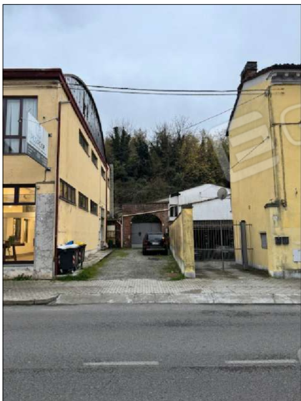
01 – Strada privata accesso da Via Roma
