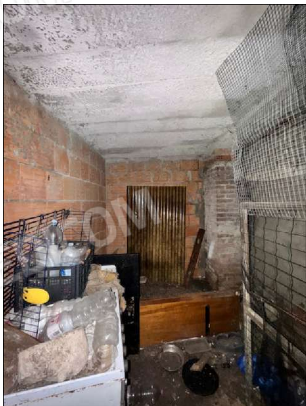
43 – Locale al rustico piano primo sottotetto (censito come ripostiglio)
