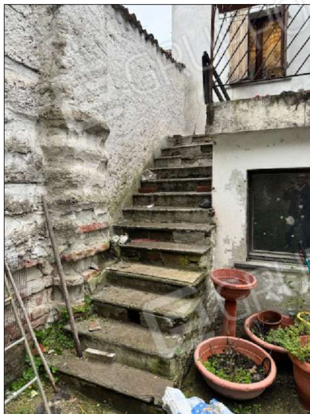
08 – Scala accesso a piano primo da cortile
