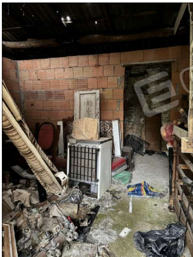
41 – Locale al rustico piano primo sottotetto (censito come ripostiglio)
