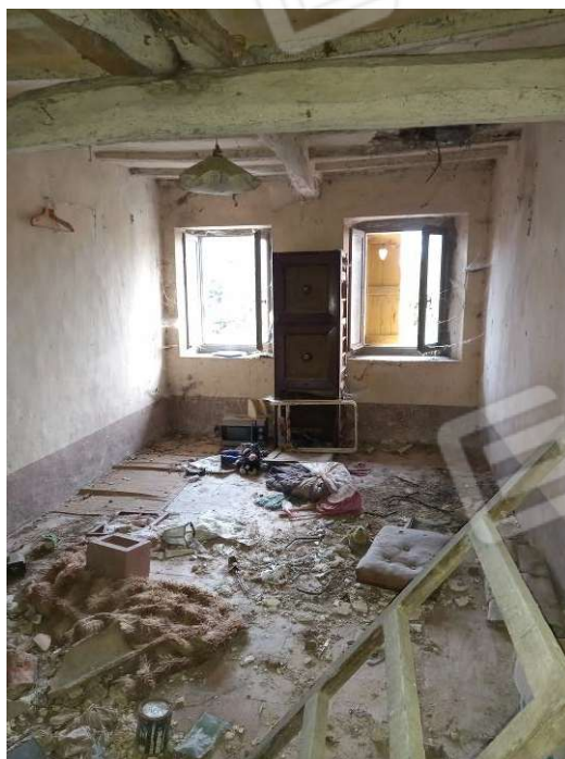
Vista interna locale Ripostiglio 4
