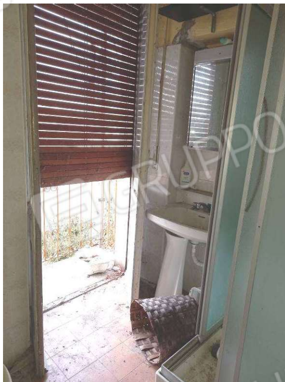
Vista interna locale Bagno
