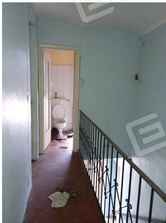
Vista interna locale Disimpegno
