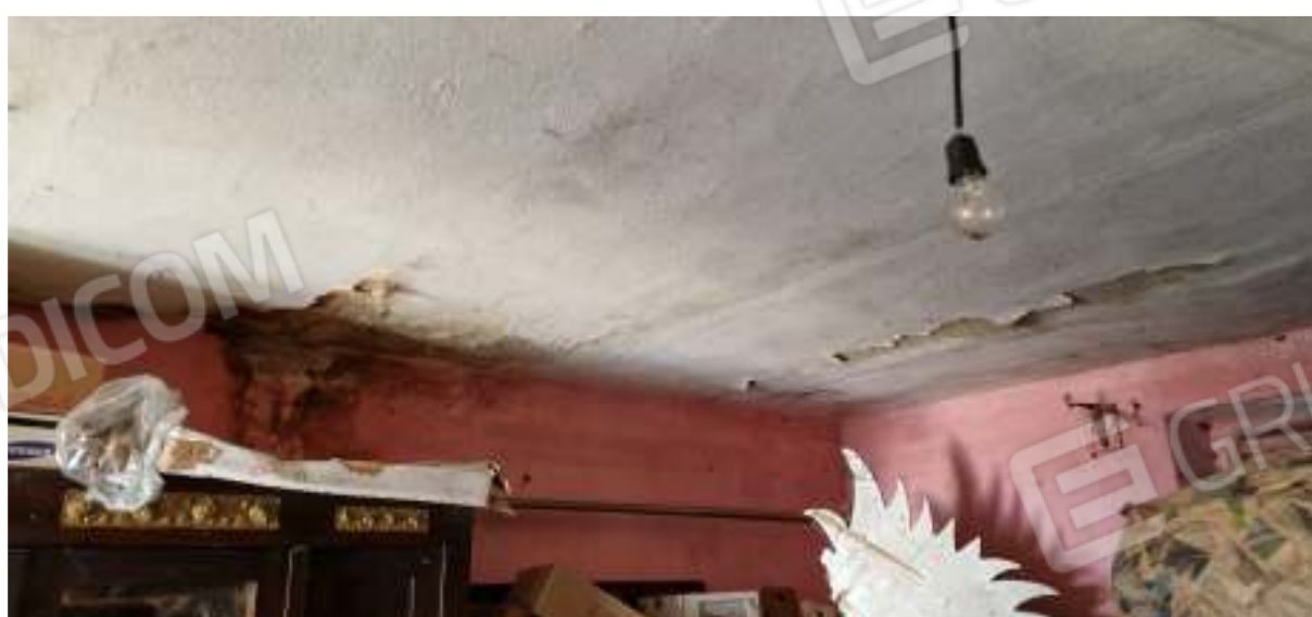
Viste del piano primo
