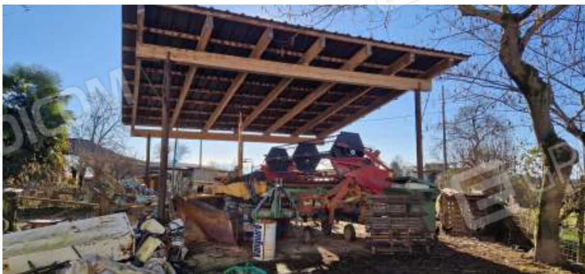
Viste esterne del fabbricato e della tettoia
