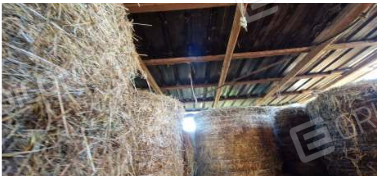
Viste della tettoia laterale
