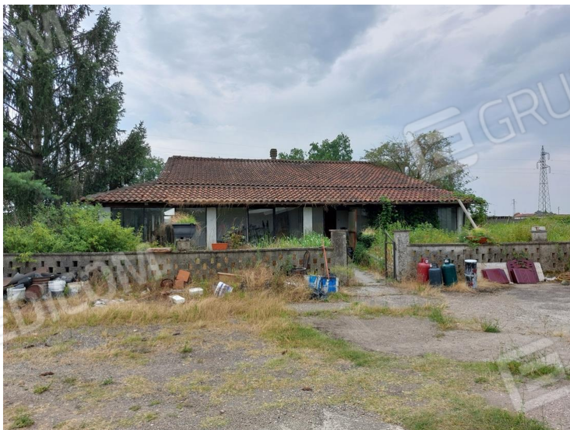
Abitazione unifamiliare Lotto 1
