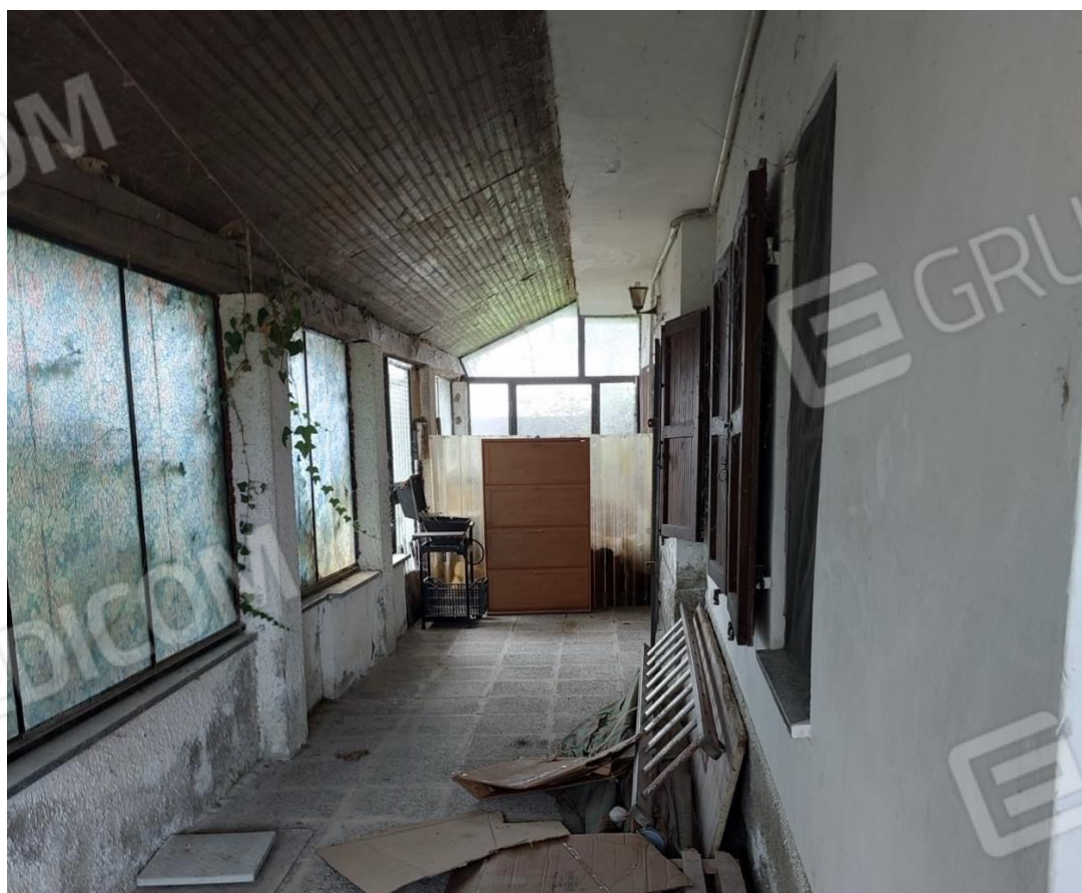
Abitazione unifamiliare Lotto 1
