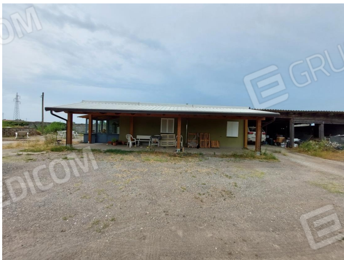
Abitazione unifamiliare Lotto 2
