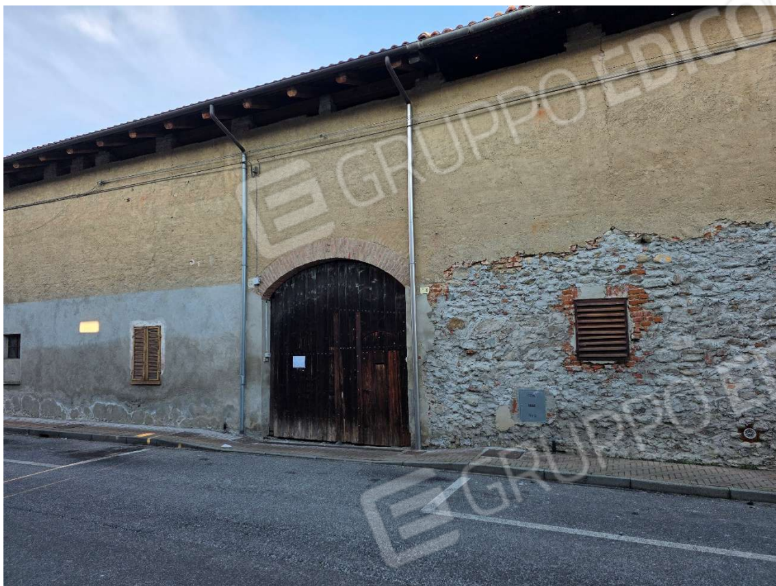
Vista dell'accesso al fabbricato da via Ivrea
