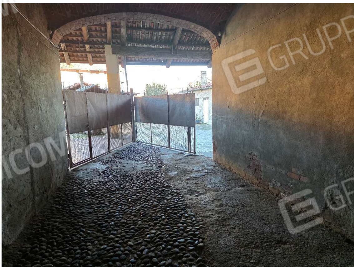
Vista dell'accesso comune
