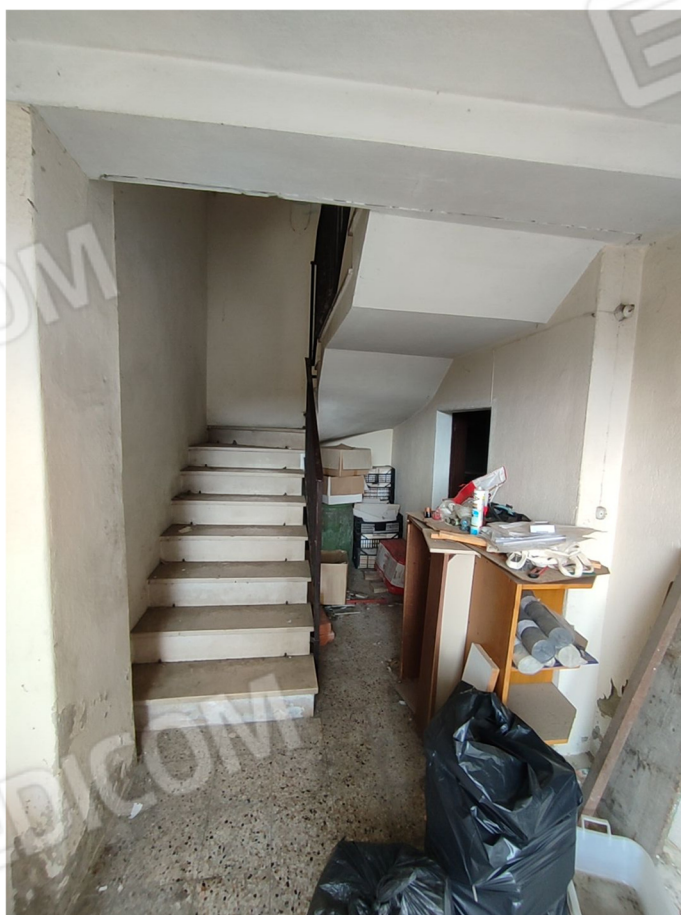
Foto 8 – piano terra vano scala
