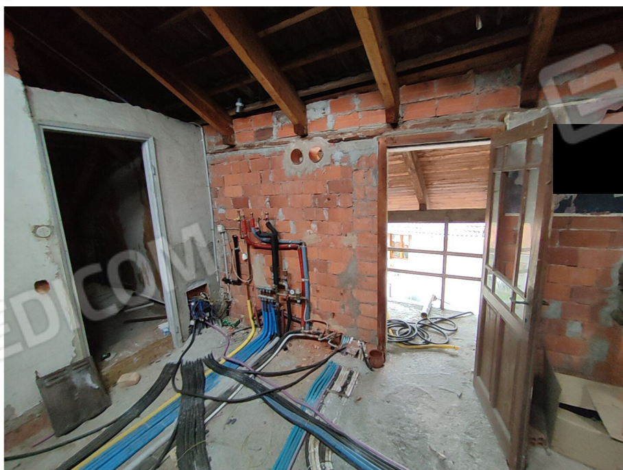
Foto 18 – piano secondo sottotetto
