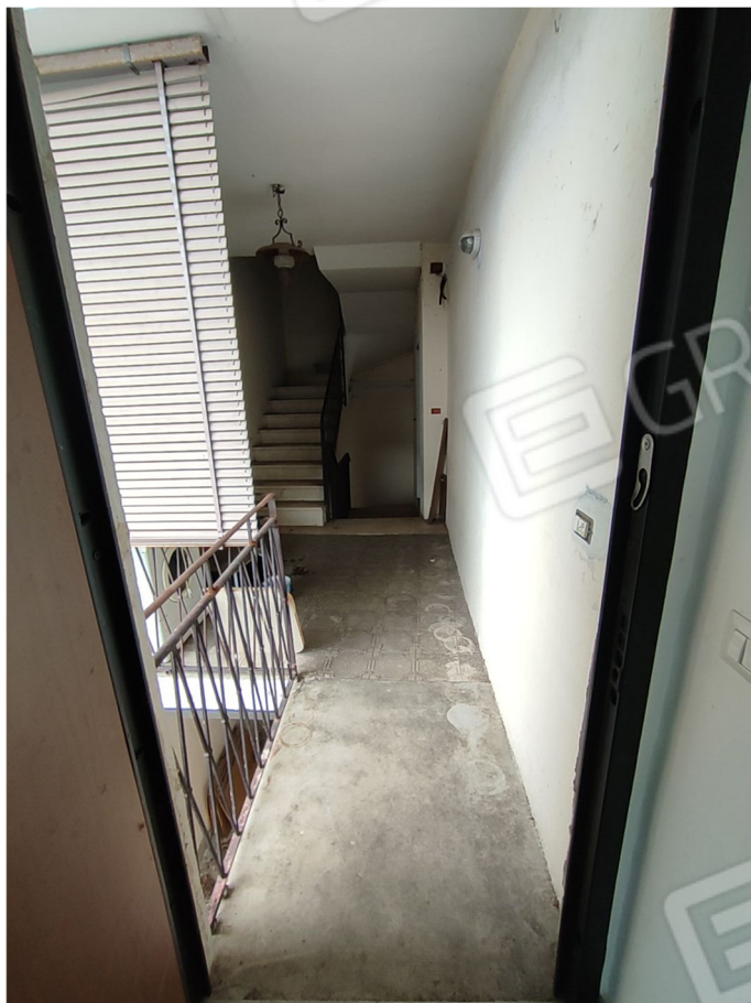
Foto 13 – piano vano scala e balcone
