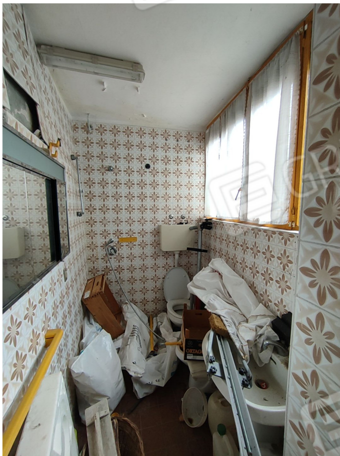
Foto 9 – piano terra bagno
