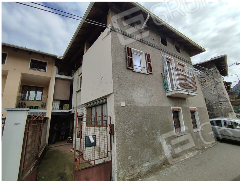
foto 1 – vista esterna lato ingresso piano terreno
