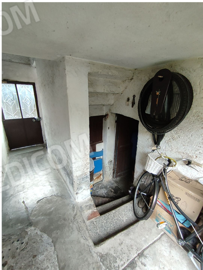
FOTO 14 scala comune, a piano terra con ingressa alla cantina
