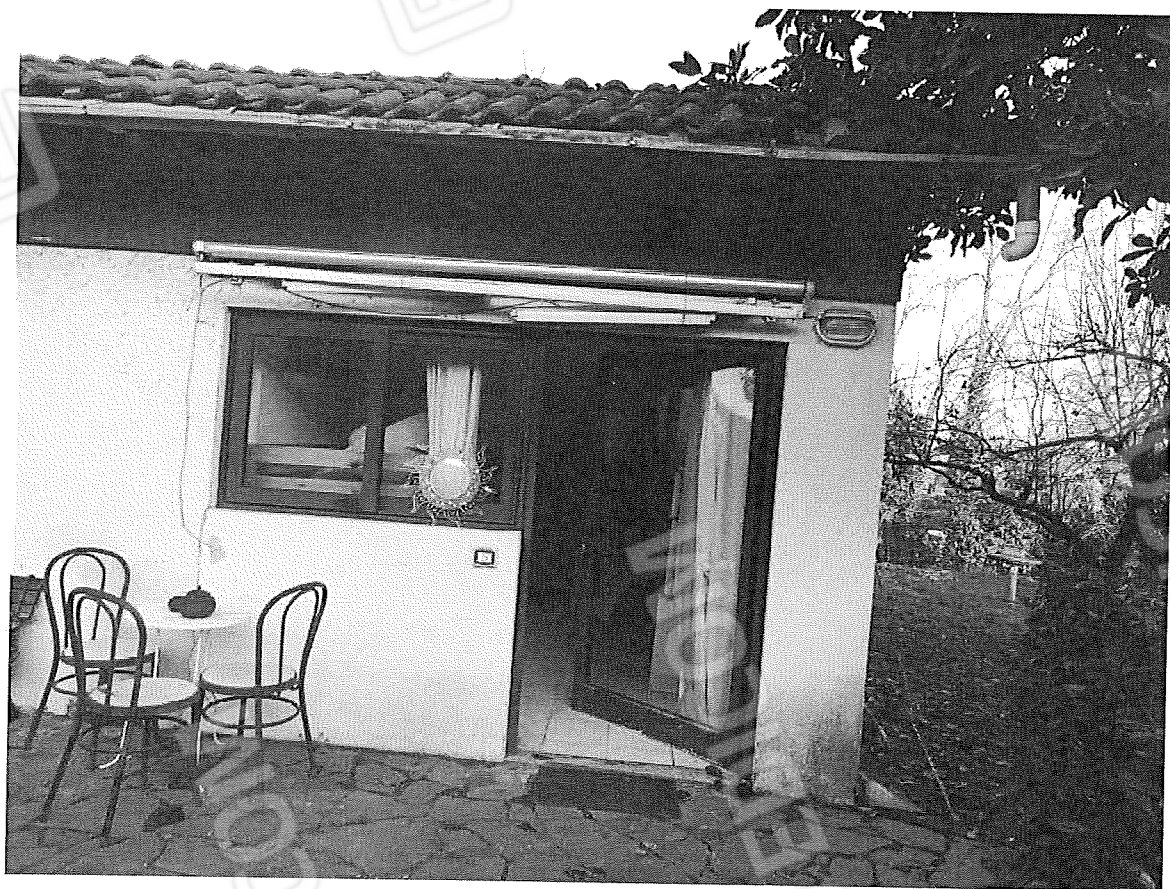
Piano terreno - Prospetto Ovest – ingresso al fabbricato
