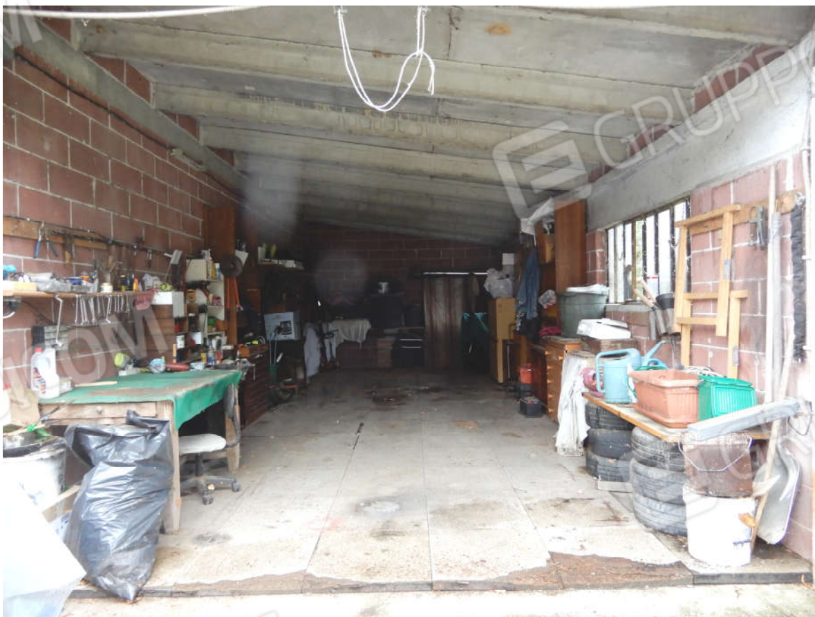
Autorimessa in continuità con il fabbricato residenziale
