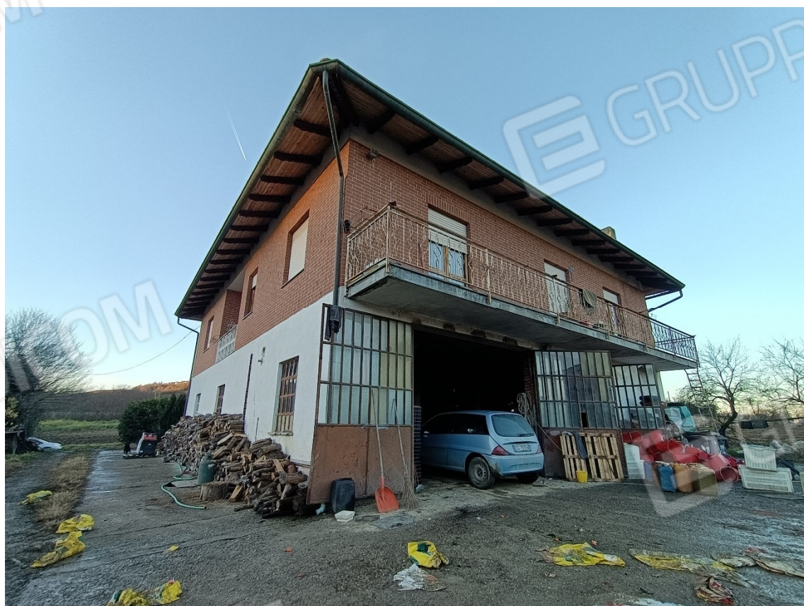
4-Fabbricato residenziale prospetto sud-est e sud-ovest
