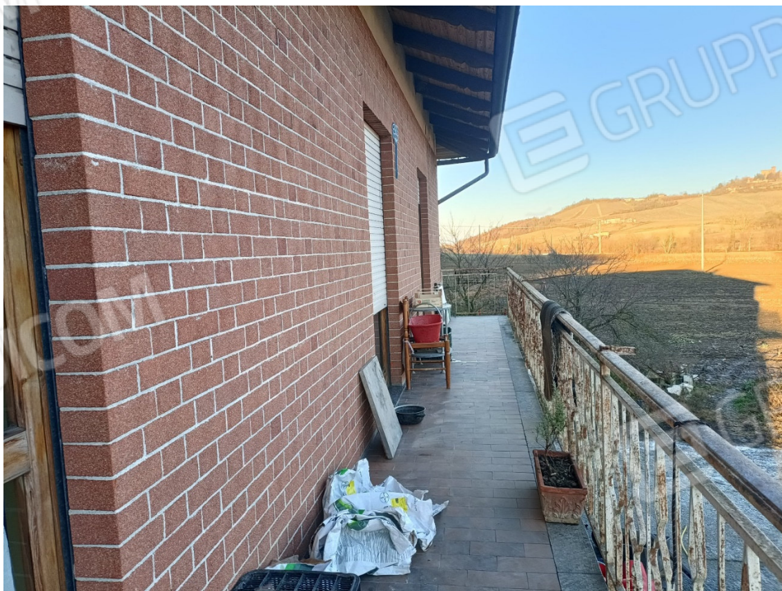
30-Abitazione: balcone prospetto sud-est
