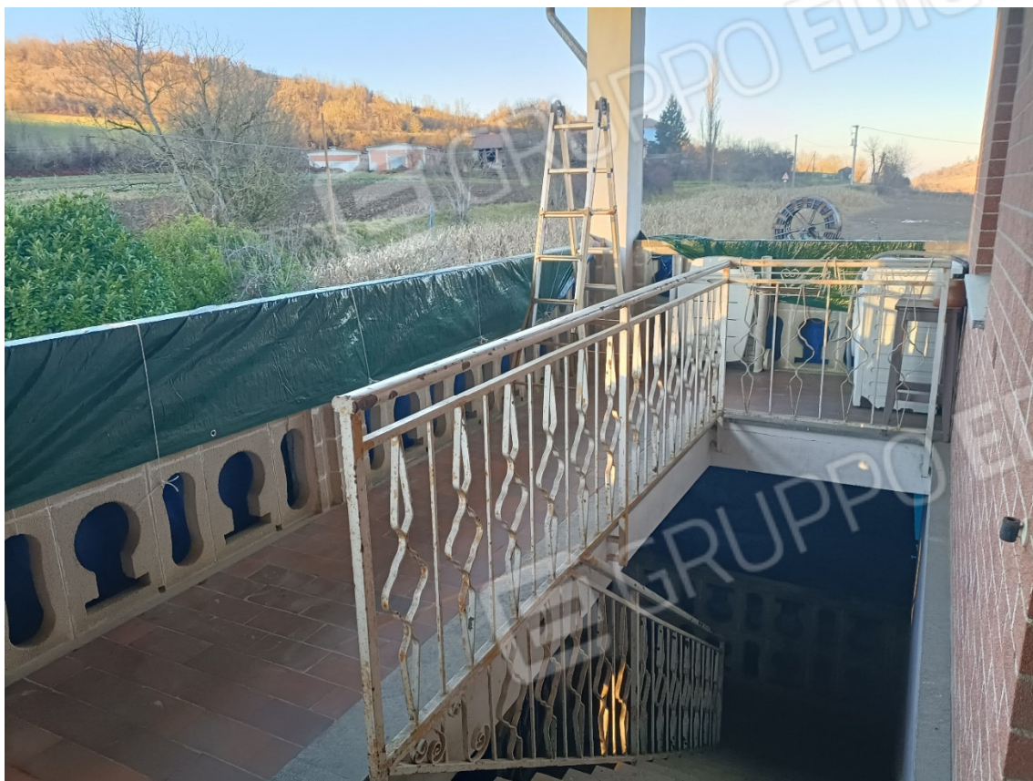
9-Abitazione: scala esterna di accesso
