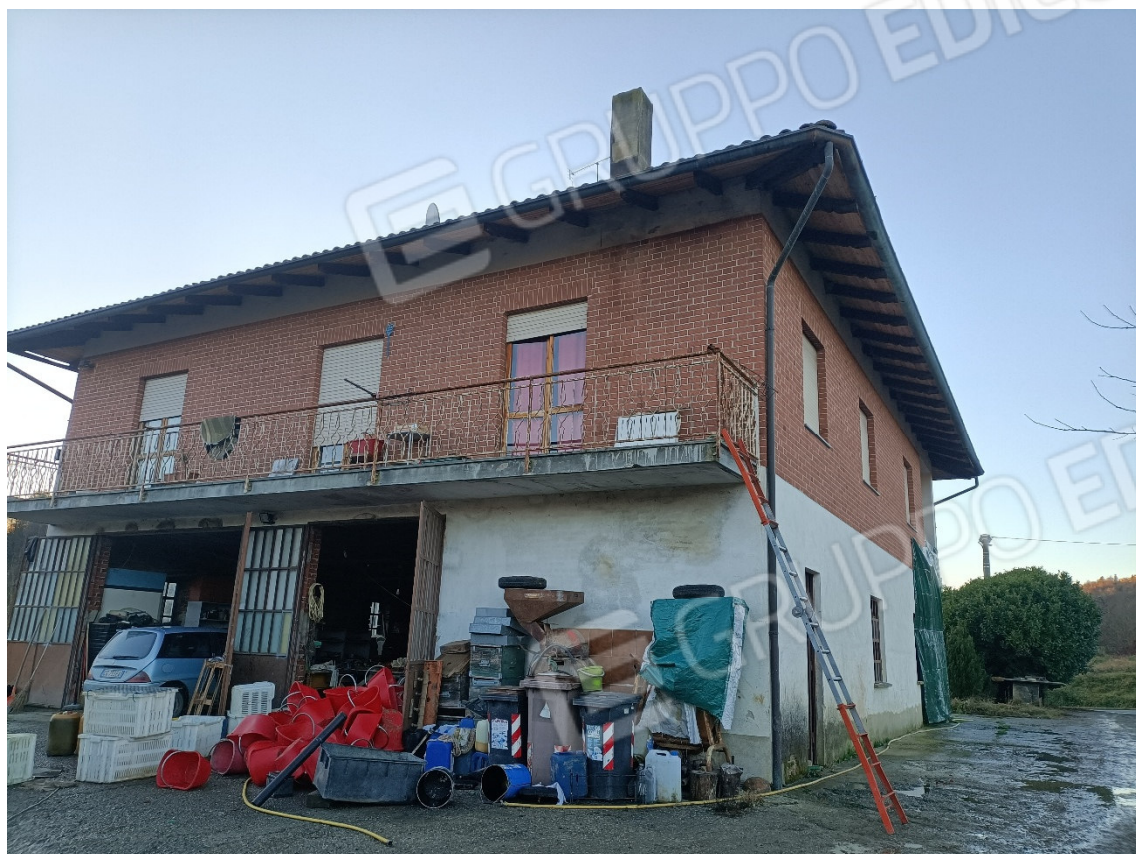
3-Fabbricato residenziale prospetto sud-est e nord-est
