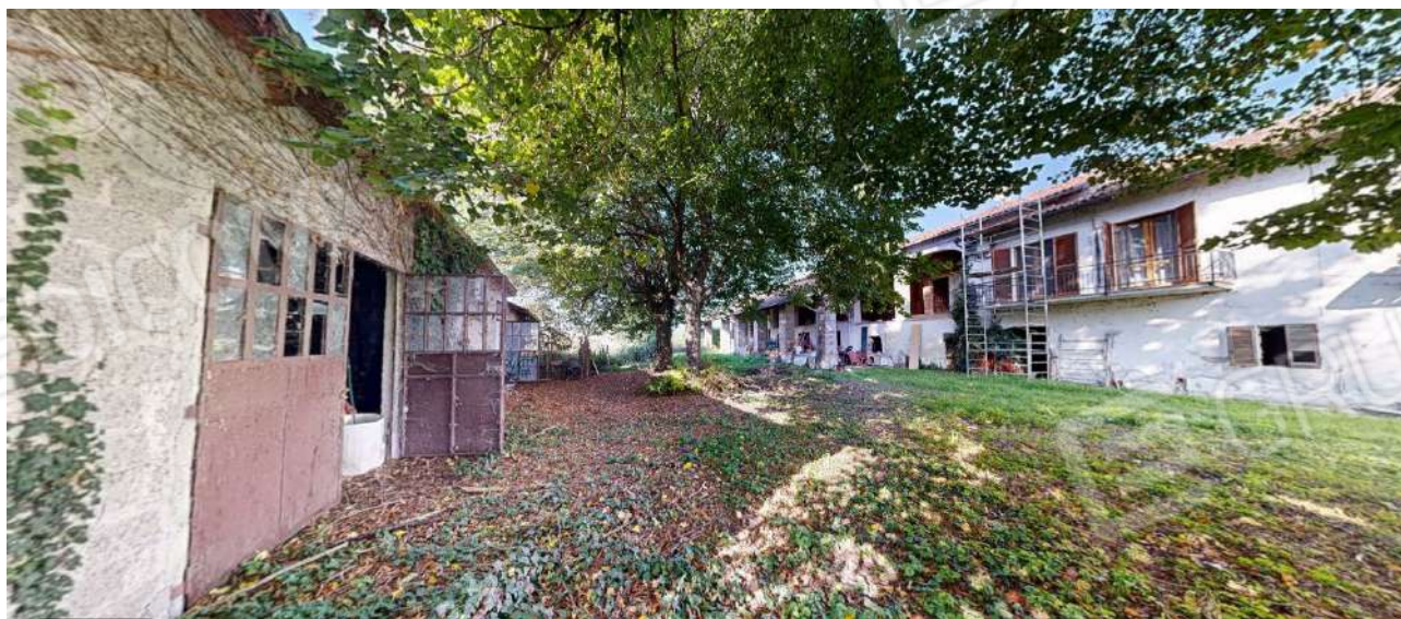
9. Vista d'insieme dei beni oggetto di stima: unità abitativa (Sub. 5), tettoia (Sub. 3), cortile comune (Sub. 1) e basso fabbricato (Sub. 5).
