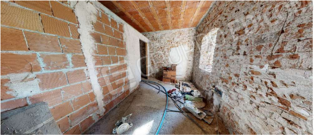
28. Locale di sgombero al rustico 4 (sub. 5-piano terra).
