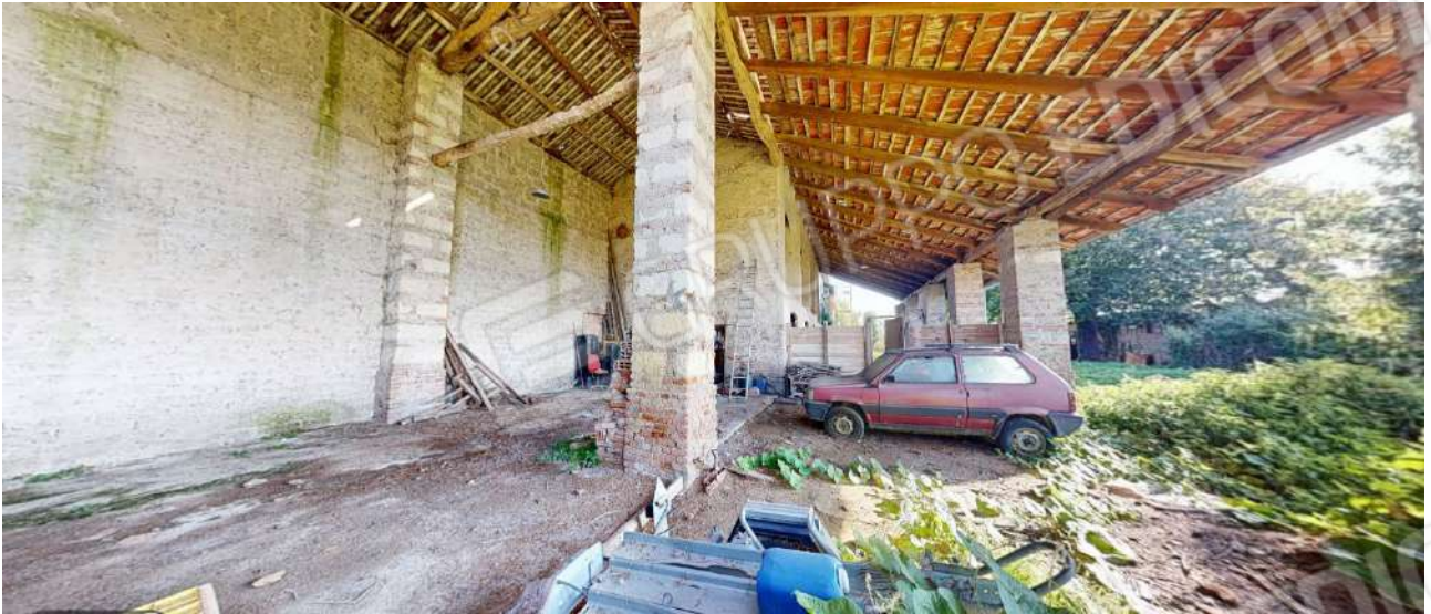
40. Vista della tettoia (sub. 3-piano terra).
