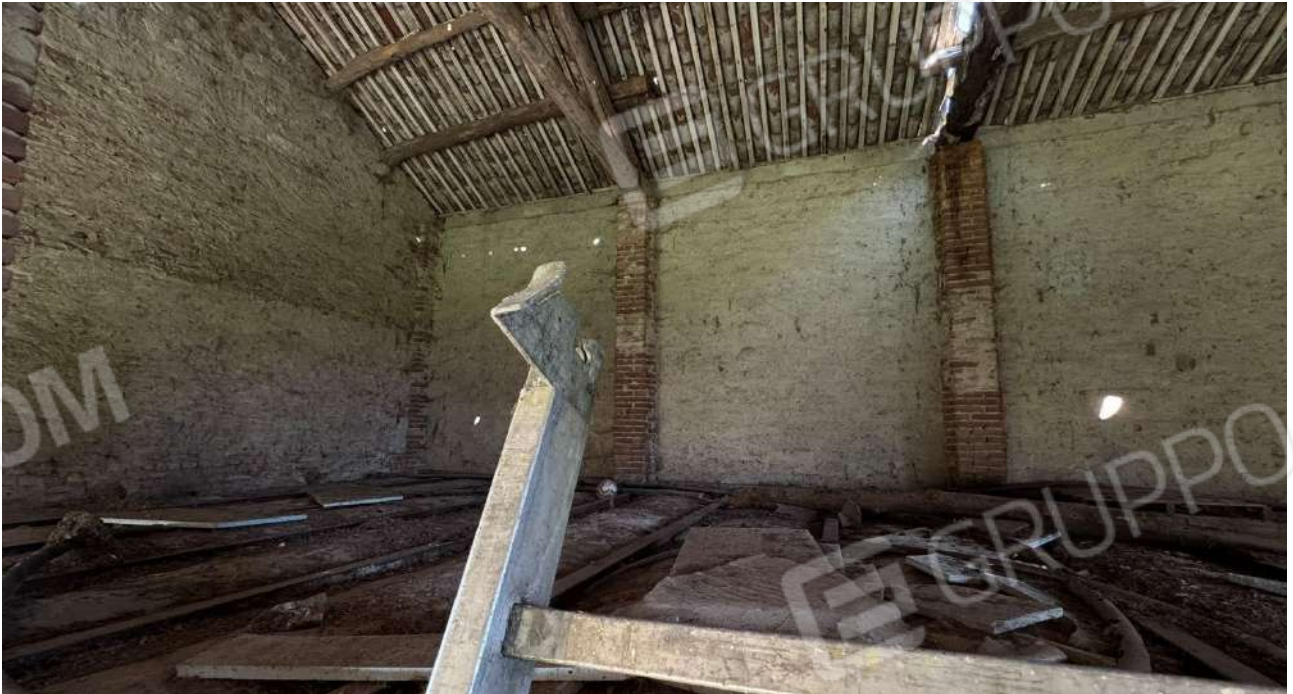
44. Ex-fienile (sub. 3-piano primo).
