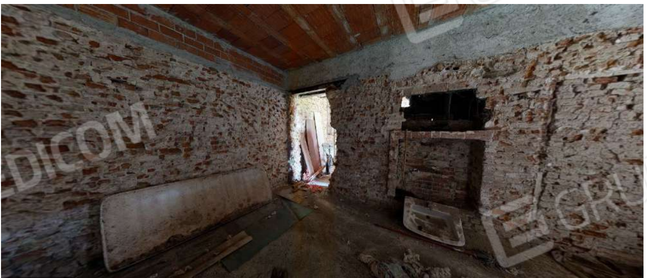
27. Locale di sgombero al rustico 2 (sub. 5-piano terra).
