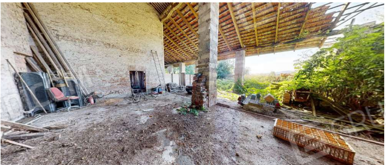
39. Vista della tettoia (sub. 3-piano terra).
