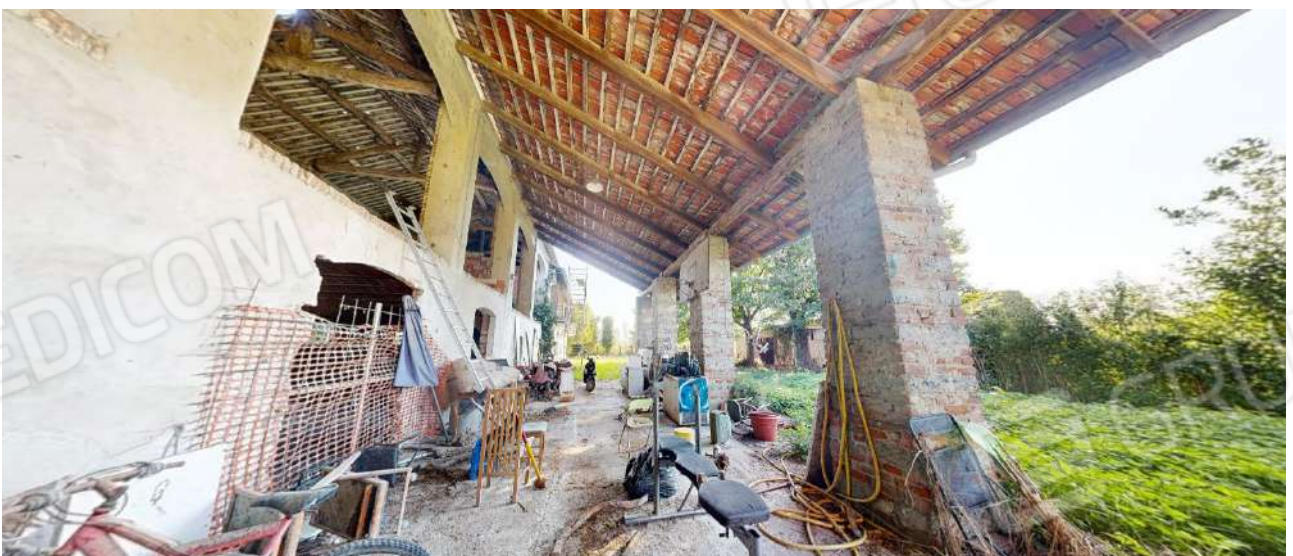
42. Vista della tettoia (sub. 3-piano terra).
