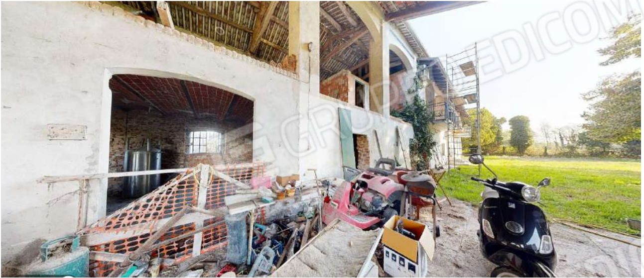
43. Vista della tettoia (sub. 3-piano terra).
