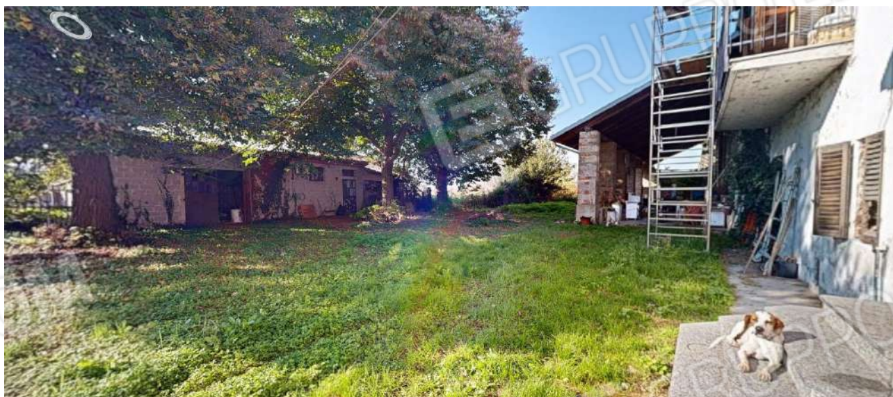
8. Vista d'insieme dei beni oggetto di stima: unità abitativa (Sub. 5), tettoia (Sub. 3), cortile comune (Sub. 1) e basso fabbricato (Sub. 5).
