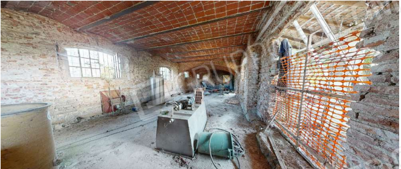
37. Deposito 1 (sub. 5-piano terra).
