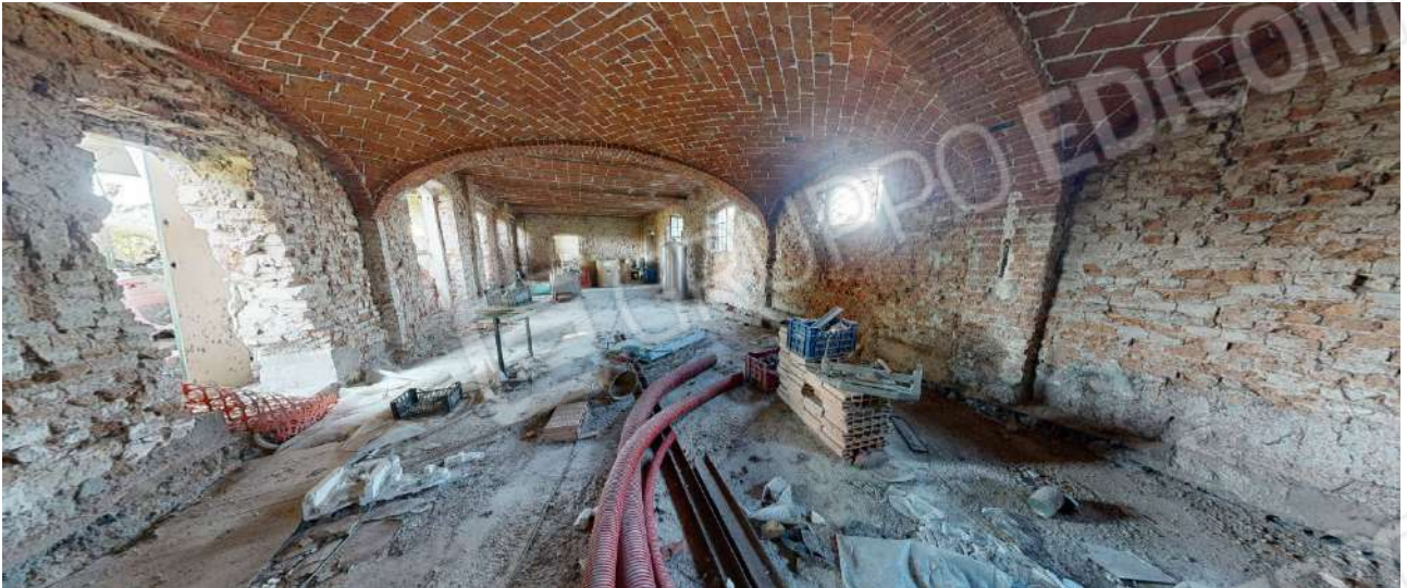
34. Deposito 1 (sub. 5-piano terra).
