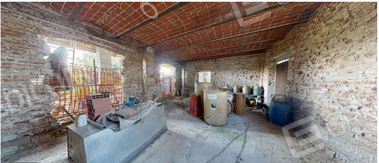
36. Deposito 1 (sub. 5-piano terra).
