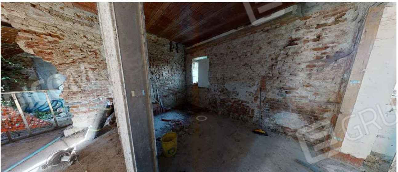
30. Locale di sgombero al rustico 3 (sub. 5-piano terra).
