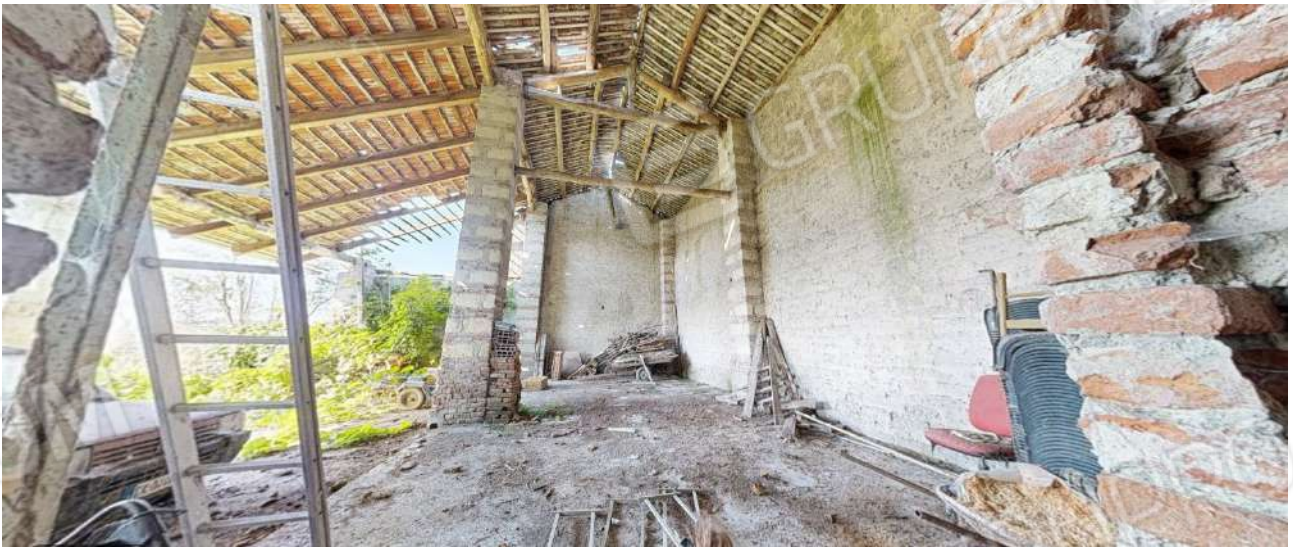
38. Vista della tettoia (sub. 3-piano terra).
