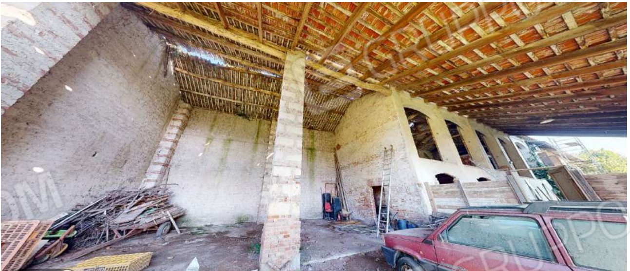
41. Vista della tettoia (sub. 3-piano terra).
