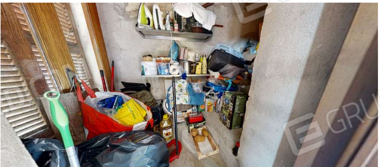
15. Scala al sottotetto (sub. 5-piano primo).
