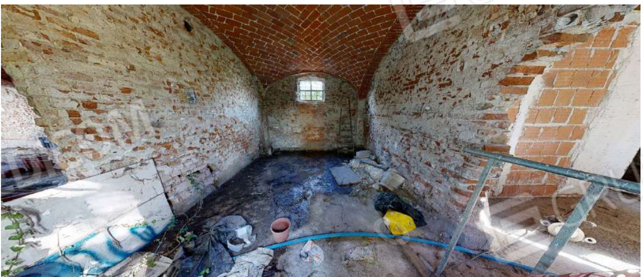
33. Locale di sgombero al rustico 5 (sub. 5-piano terra).
