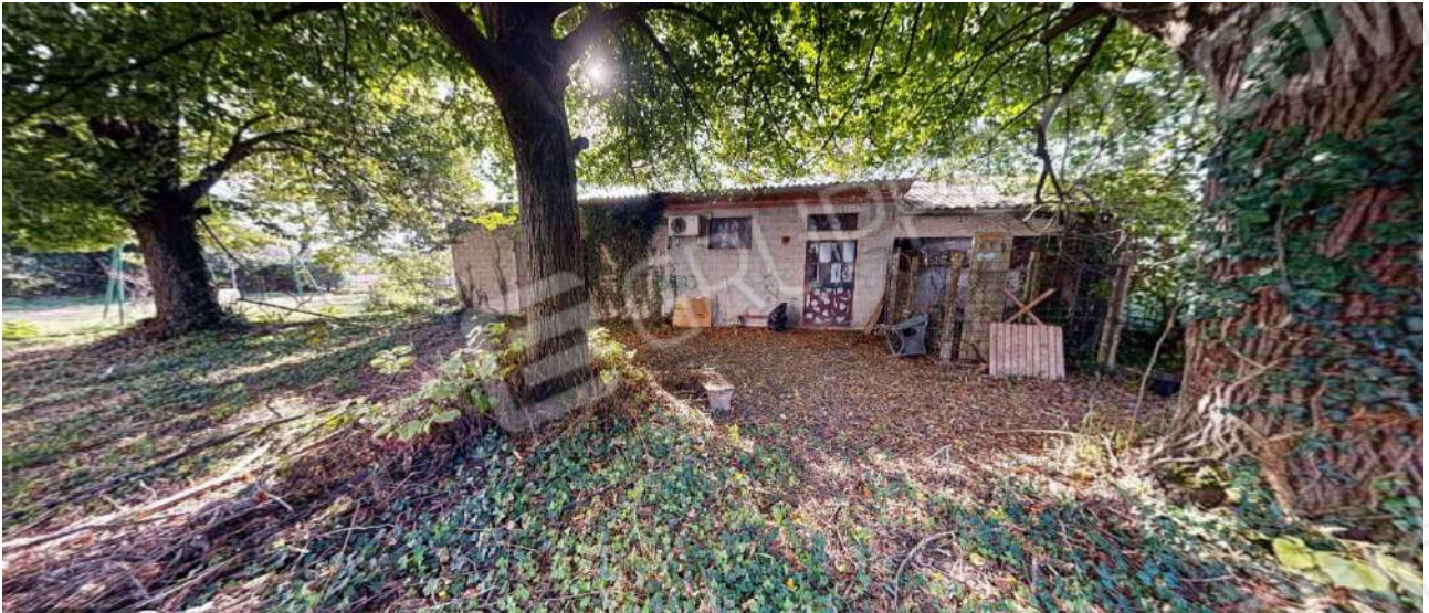
10. Vista del basso fabbricato (Sub. 5).
