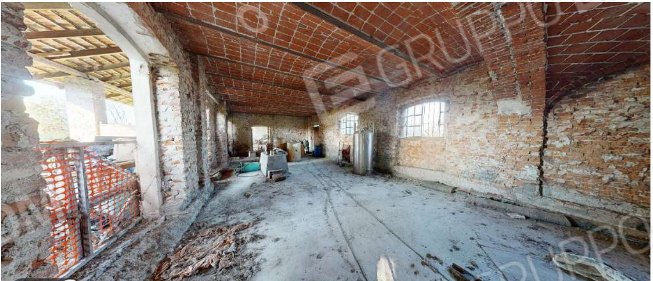
35. Deposito 1 (sub. 5-piano terra).
