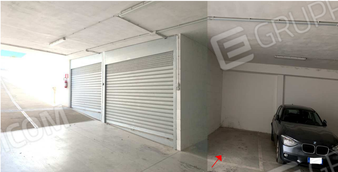
Foto n. 11. Piano S1. Posto auto coperto
