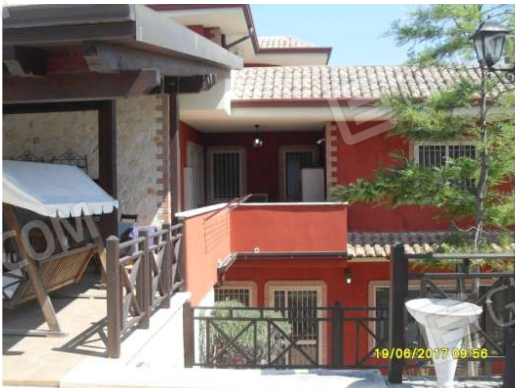
N. 10 FACCIATA SUD
