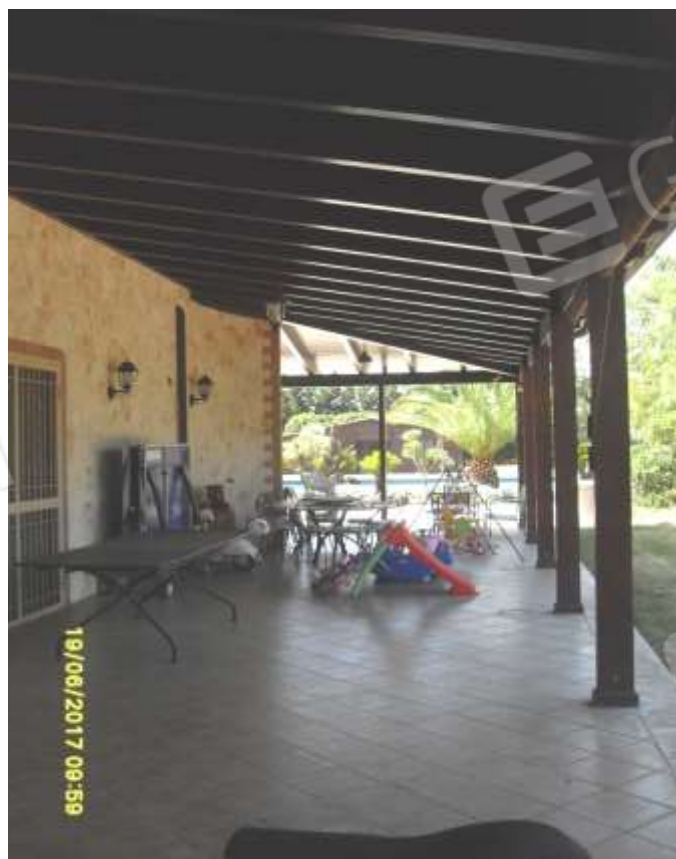
N. 16 VISTA SPAZIO TETTOIA A OVEST
