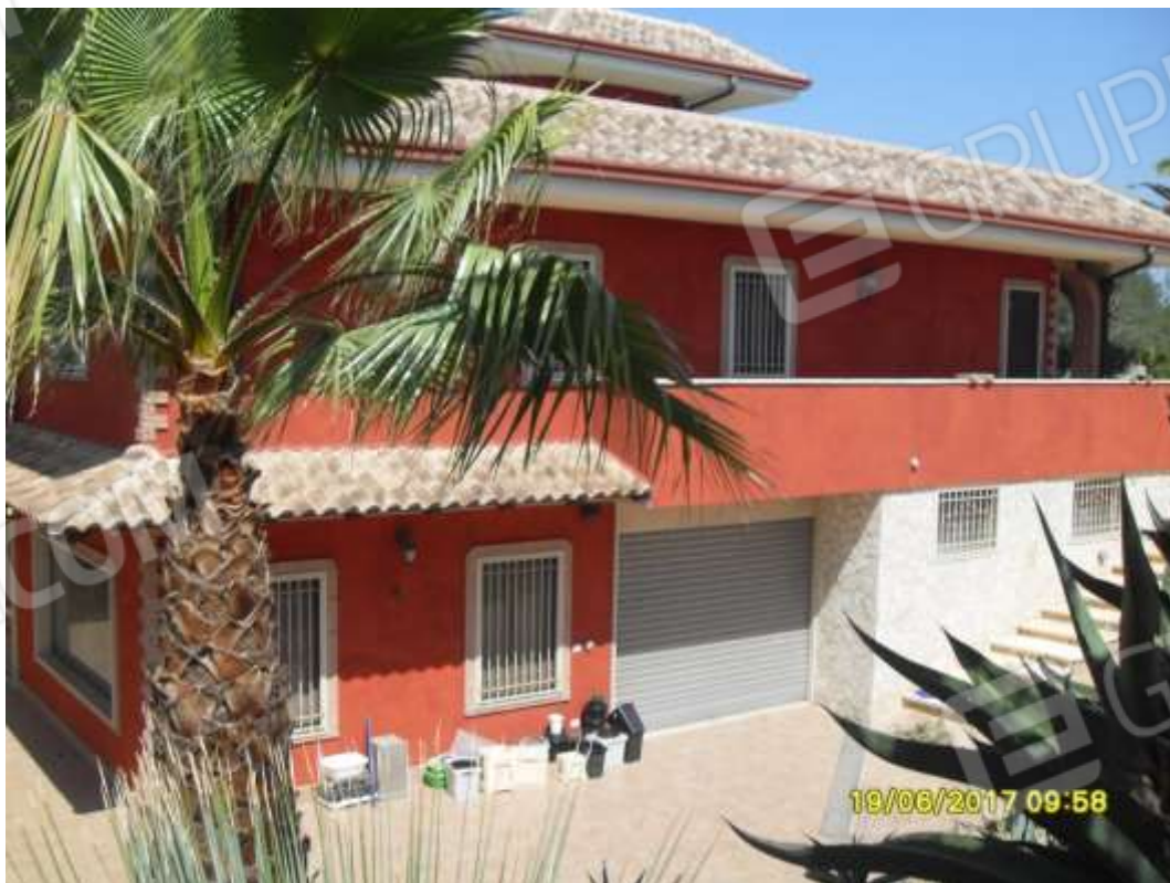
N. 12 VISTA FACCIATA EST
