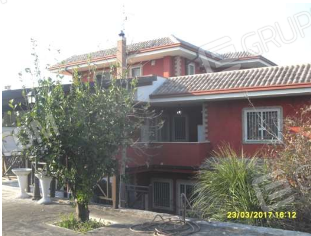
N. 8 VISTA FACCIATA SUD
