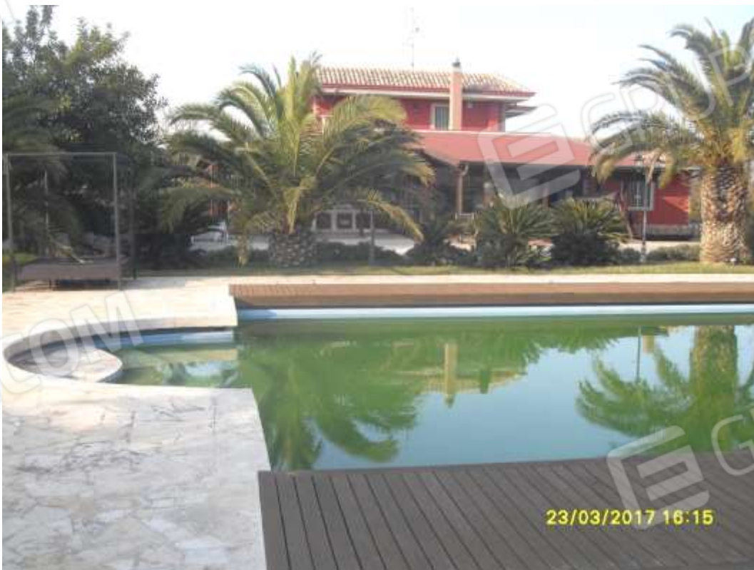
N. 18 VISTA PISCINA E FACCIATA SUD
