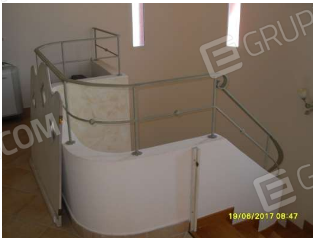
N. 54 VANO SCALA
