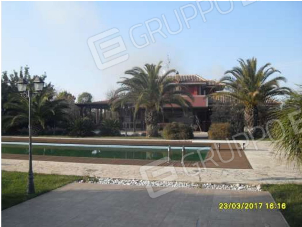
N. 19 VISTA PISCINA E FACCIATA SUD
