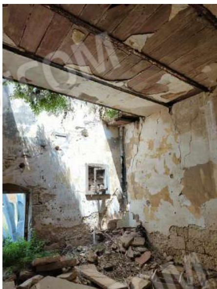
Foto 61 - Vista del vano a p.t. sul lato Ovest - Particolare traccia di imposta delle scale
