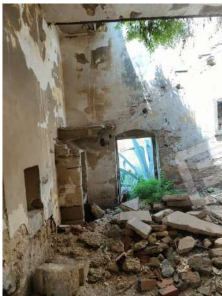
Foto 58 - Vista del vano a p.t. sul lato Ovest - Particolare traccia di imposta delle scale
