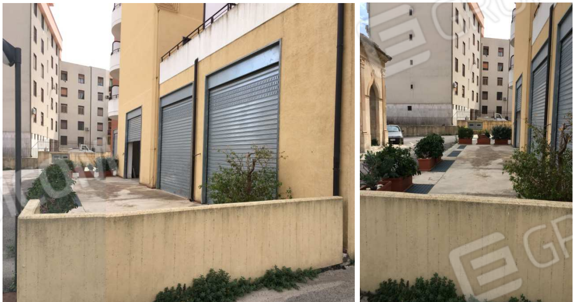
Foto nn. 4-5. Piano Terra. Area di pertinenza
