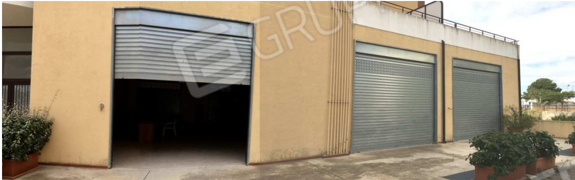
Foto n. 6. Piano Terra. Autorimessa con annessa area di pertinenza
