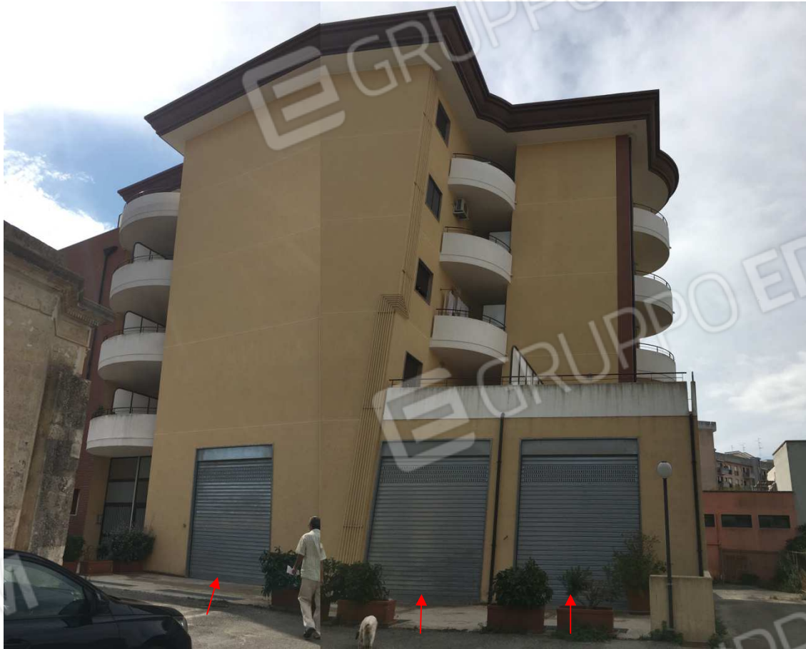
Foto n. 3. Piano Terra. Autorimessa
