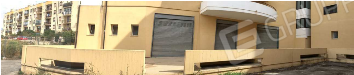
Foto n. 17. Piano Terra. Area di pertinenza (parte retrostante)
