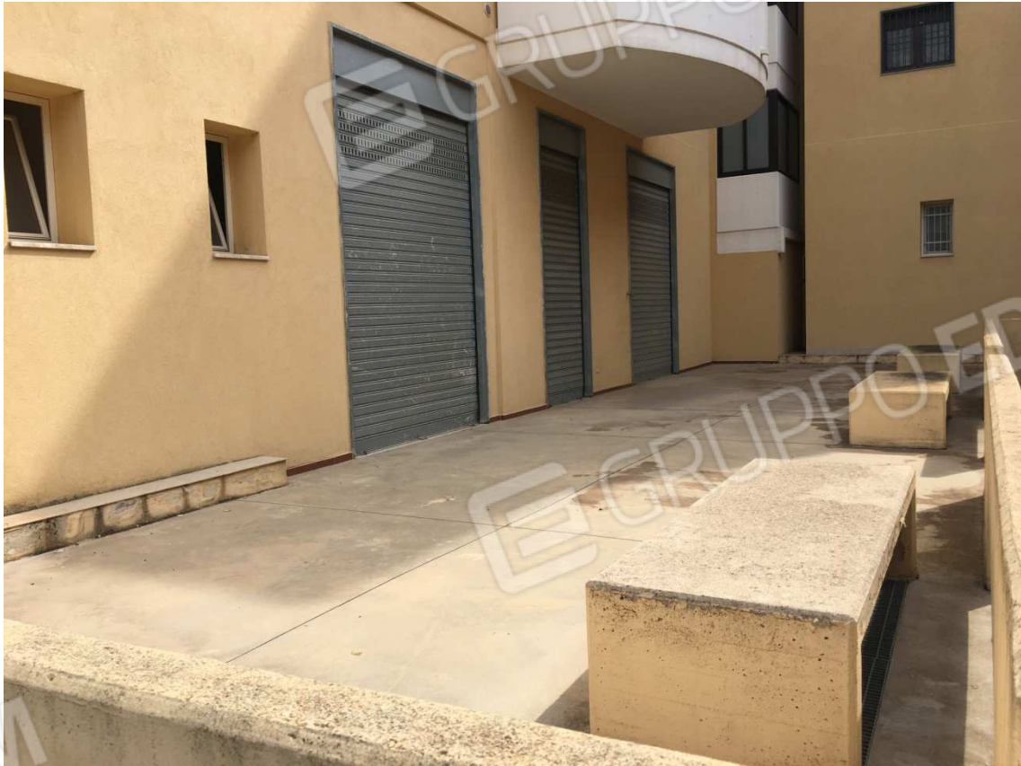
Foto n. 16. Piano Terra. Area di pertinenza (parte retrostante)
