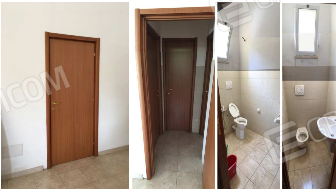
Foto nn. 12-13-14-15. Piano Terra. Bagno
