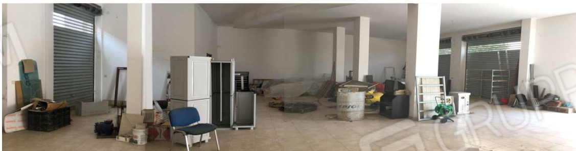
Foto n. 8. Piano Terra. Autorimessa
