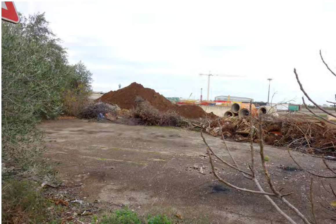
Vista dell'area del lotto (si noti nell'area accumulo di macerie e stoccaggio di materiale vario)
