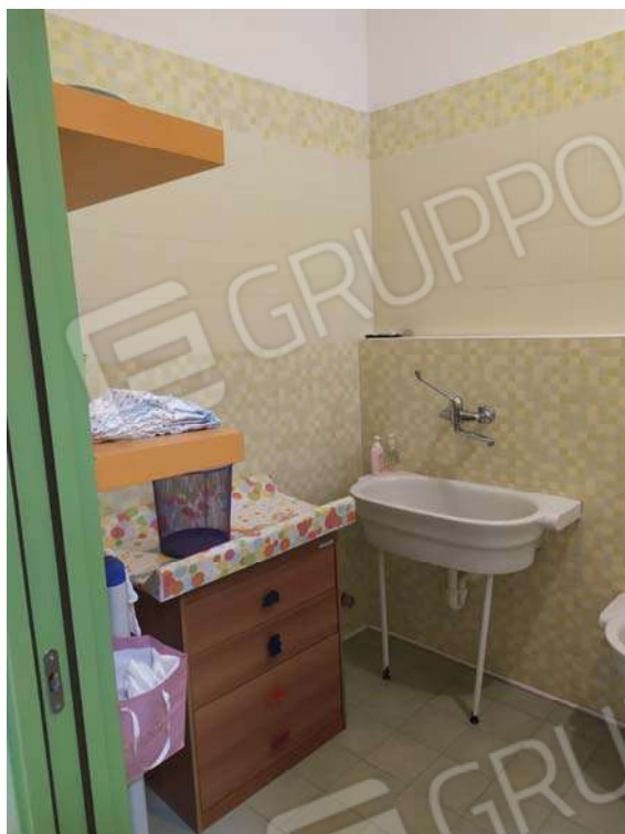
Foto 13 – servizio igienico accessibile dall'ambiente relativo alla foto n. 9 (funzionale all'attività svolta nell'immobile)
