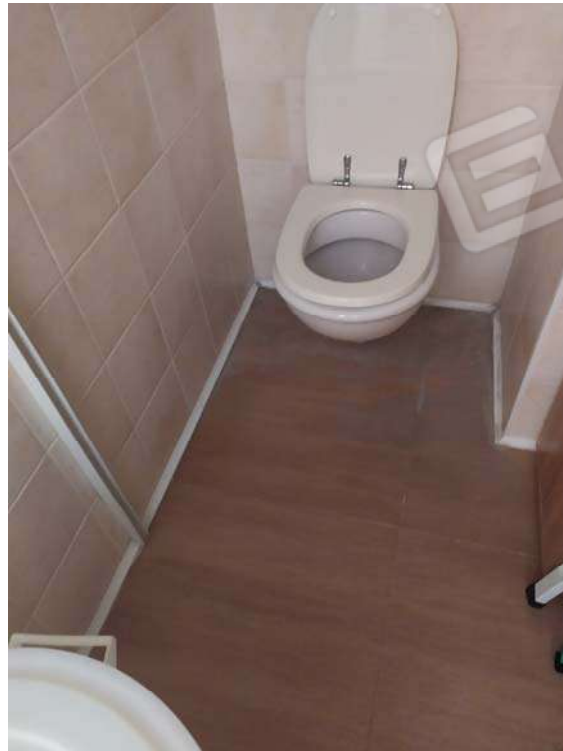
Foto 10 – servizio igienico a servizio della cucina
