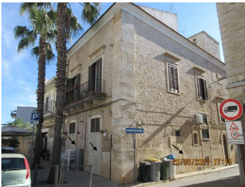
Foto n.1 : Prospetto del locale Via Grumo (palme) con Via Piscinelle
