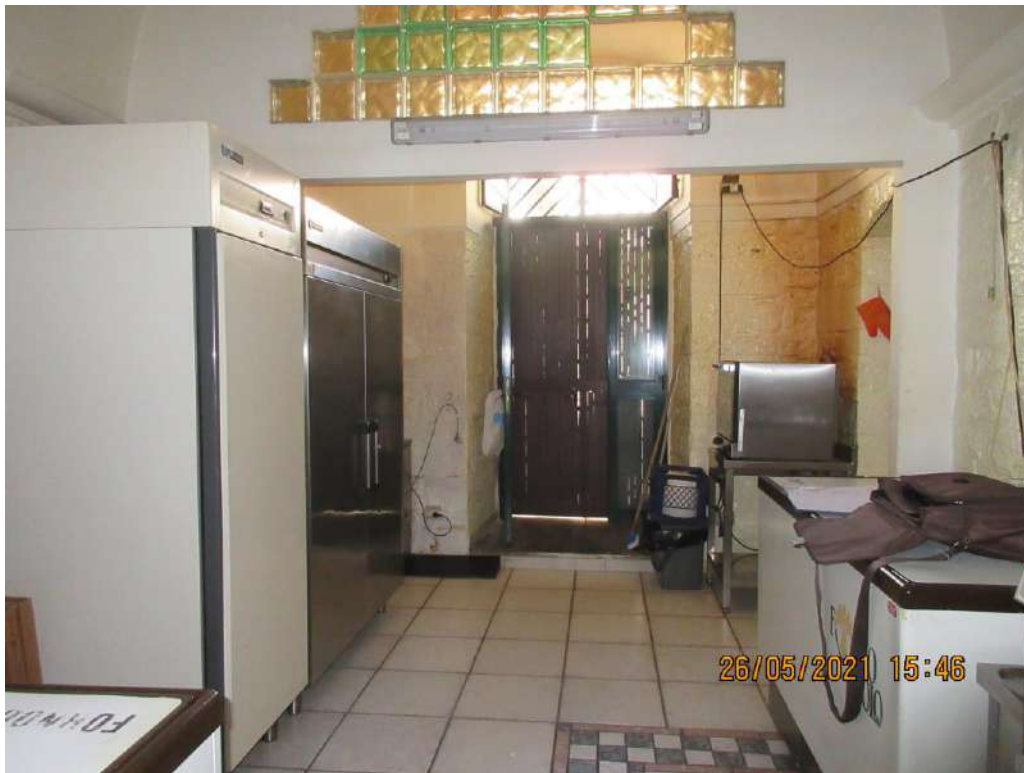
Foto n. 5 Ambiente n. 1 della planimetria in corrispondenza del civico n.1 di Via Grumo, Binetto
