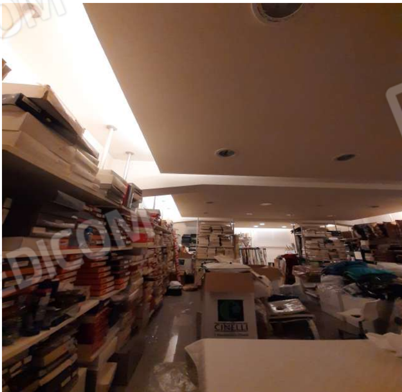
Foto n. 10 Piano interrato vista alla base delle scale
