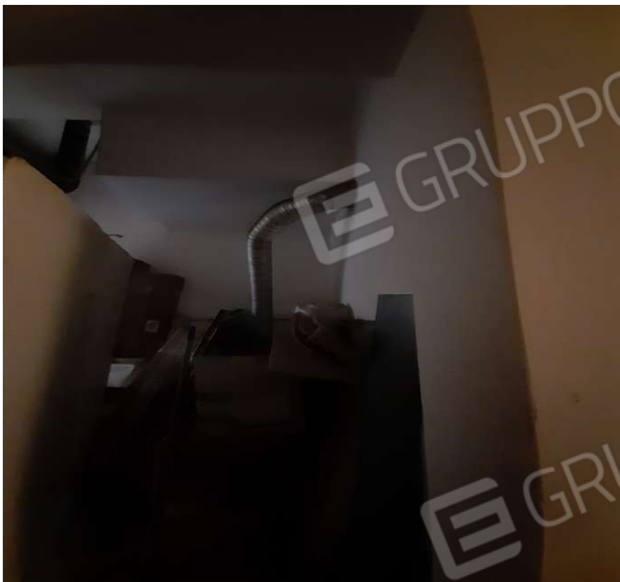
Foto n. 18 Locale C.T. in disuso
