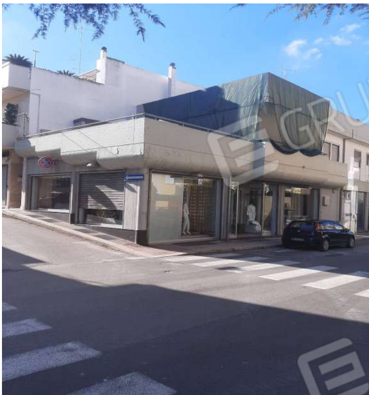
Foto n. 1 Vista complessiva dei prospetti
