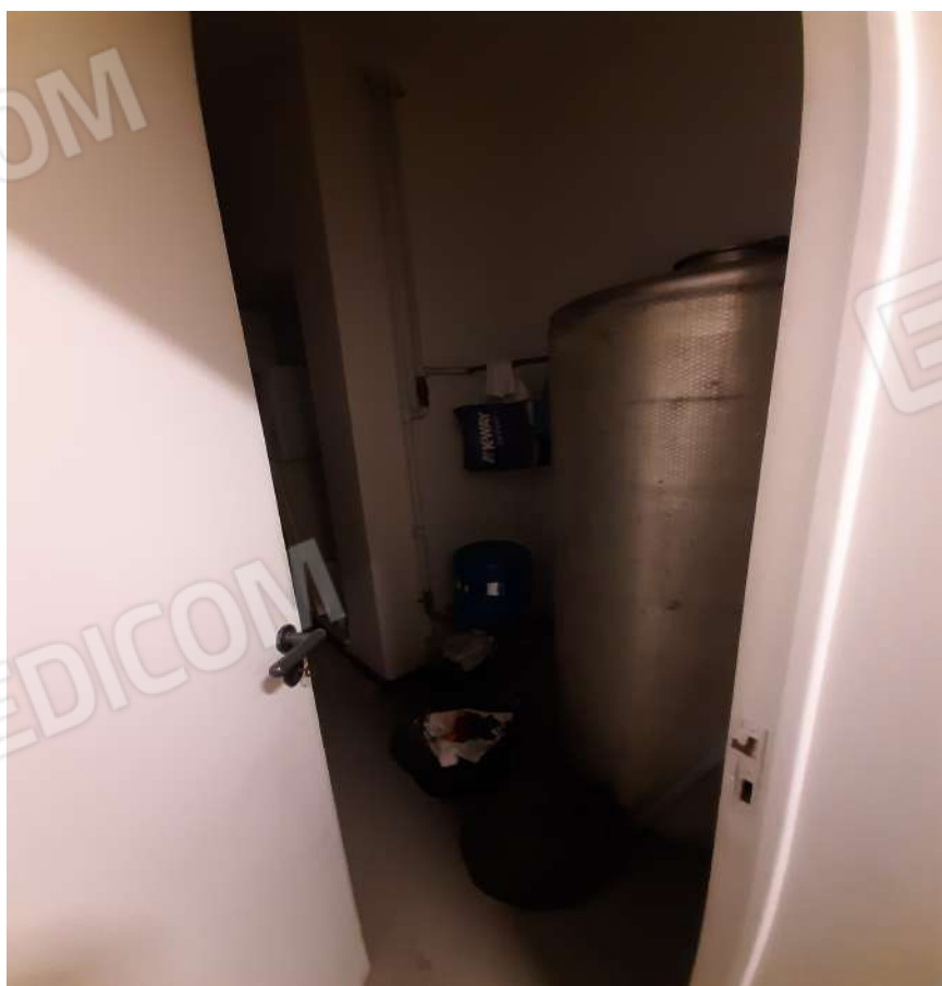
Foto n. 17 Locale C.I. in disuso
