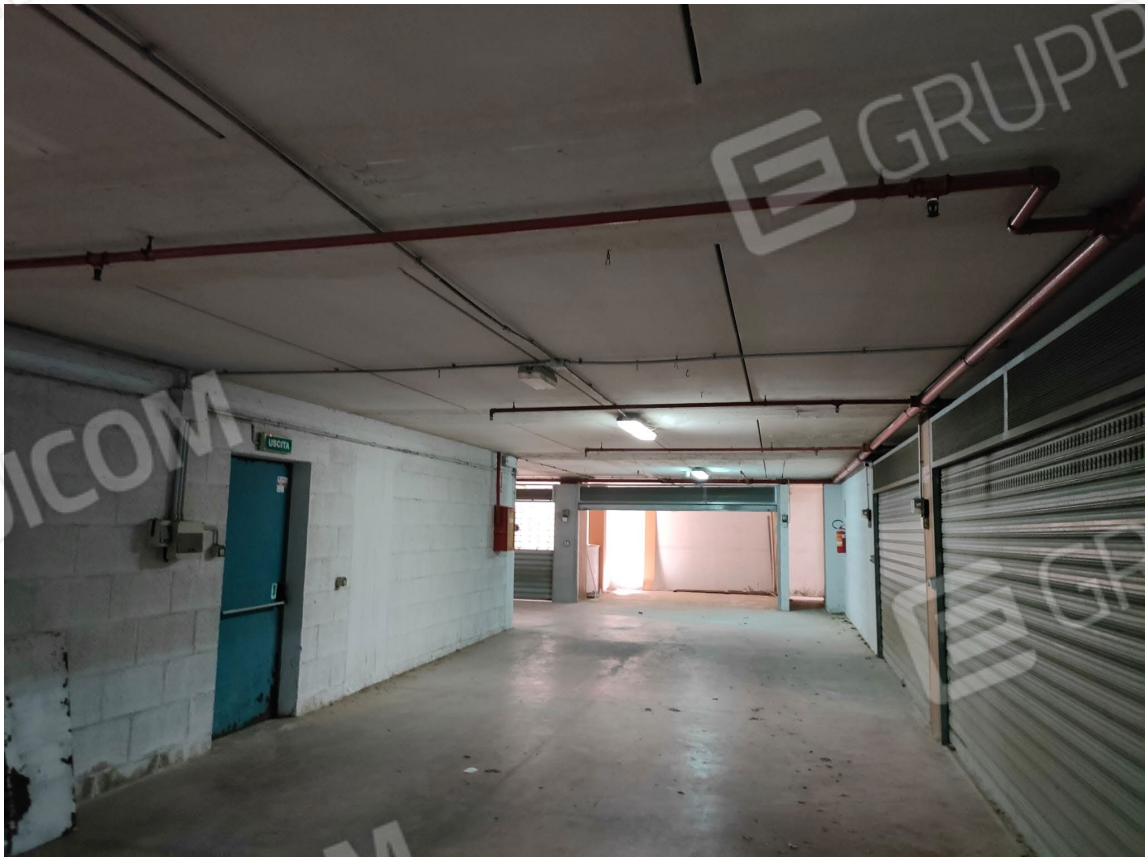
Foto n.2: vista spazio di manovra.
