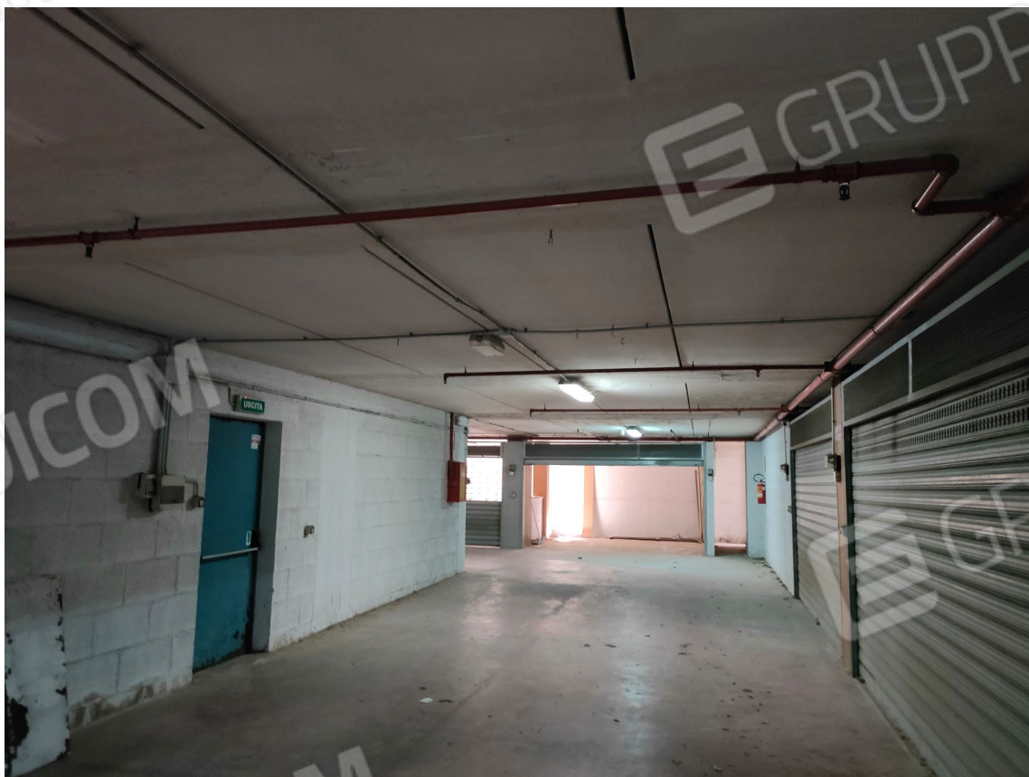
Foto n.2: vista spazio di manovra.
