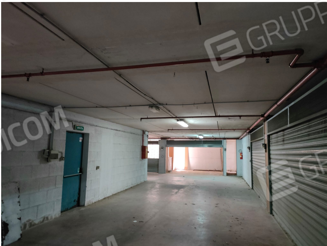
Foto n.2: vista spazio di manovra.
