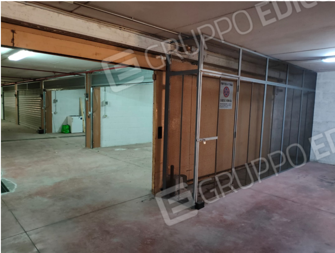
Foto n.1: vista ingresso ai posti auto.
