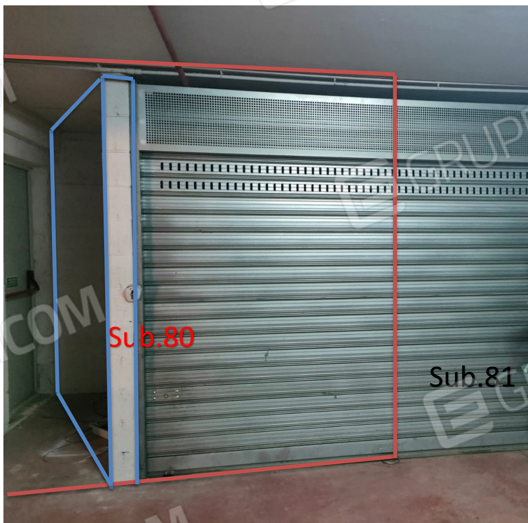
Foto n.4: vista posto auto - muratura da eliminare (blu) confinante con ingresso.
