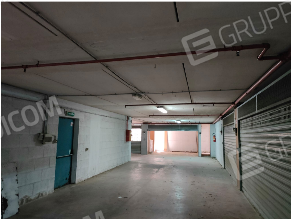
Foto n.2: vista spazio di manovra.
