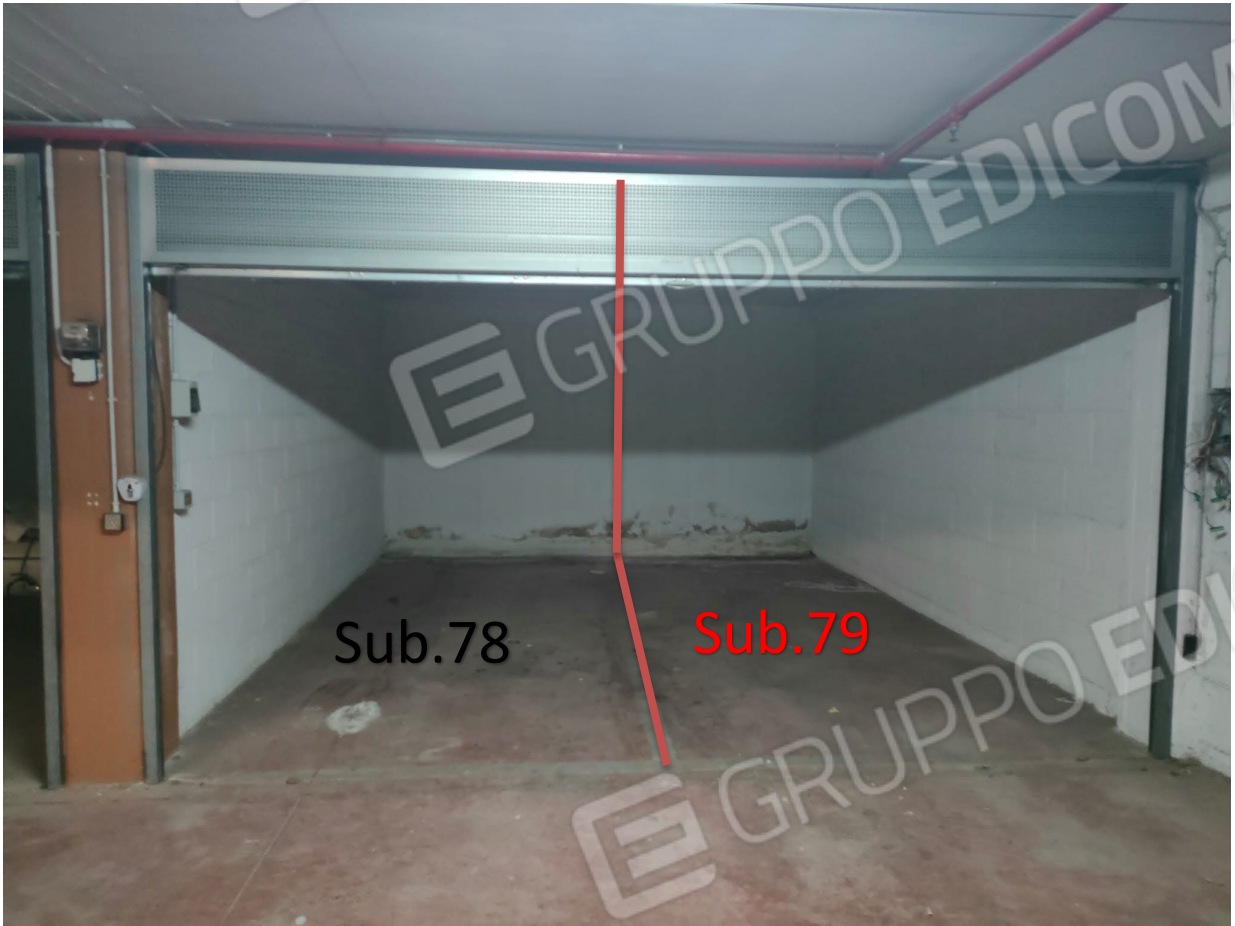
Foto n.3: vista posto auto.
