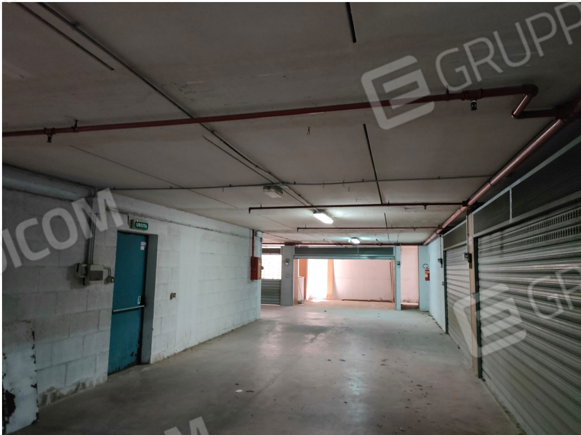
Foto n.2: vista spazio di manovra.
