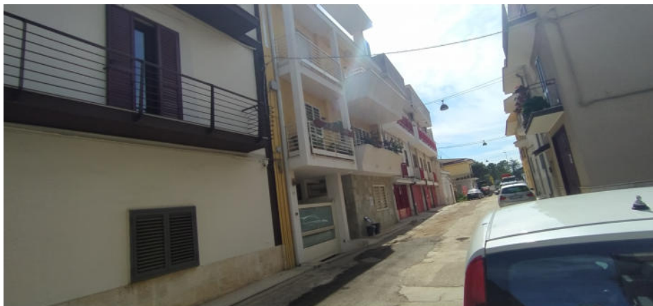
Palazzina alla via Professore Scalera 29
