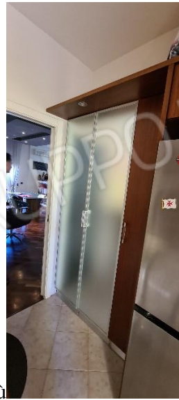
porta ingresso lavatoio a sx entrando in cucina
