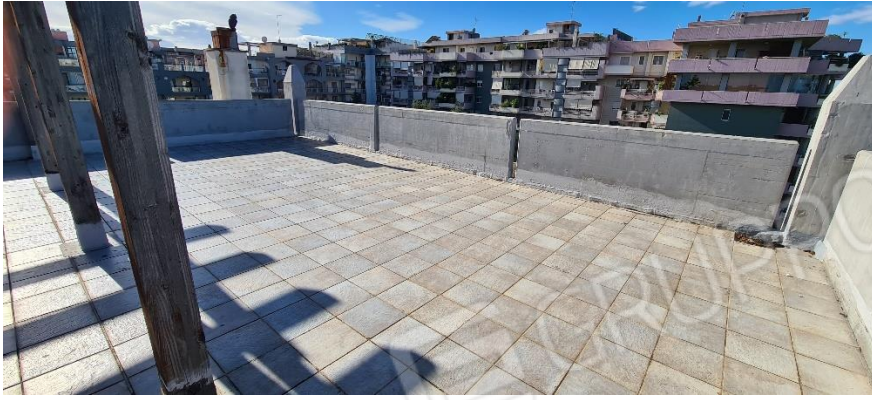
porzione priva di struttura lignea al 6° piano
