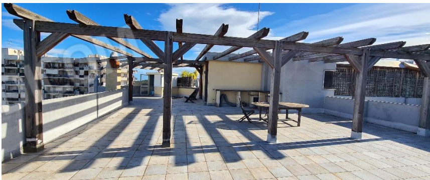
struttura lignea sul lastrico solare al 6° piano
