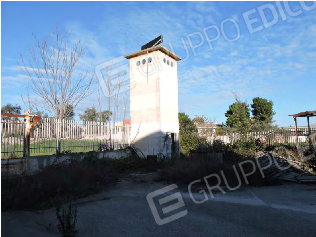
Ex cabina elettrica – p.IIa 82
