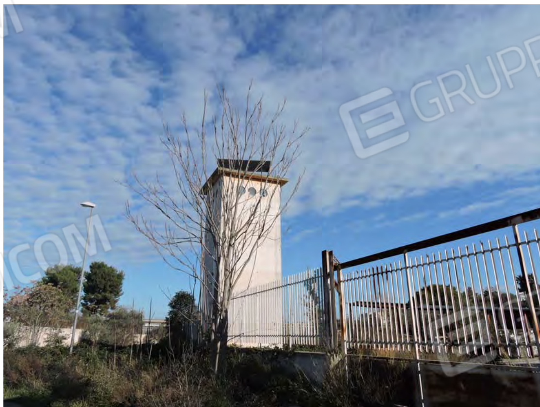
Ex cabina elettrica – p.IIa 82
