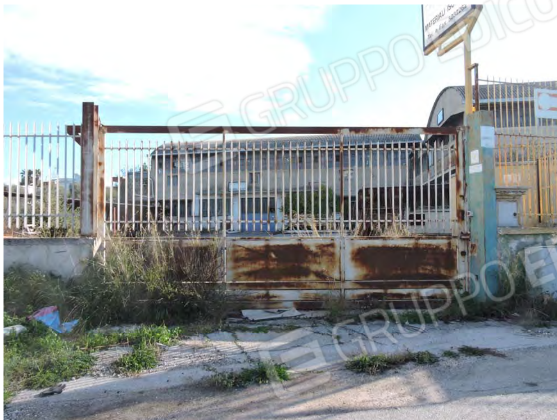
Accesso – strada Fondo Capillo del Campo
