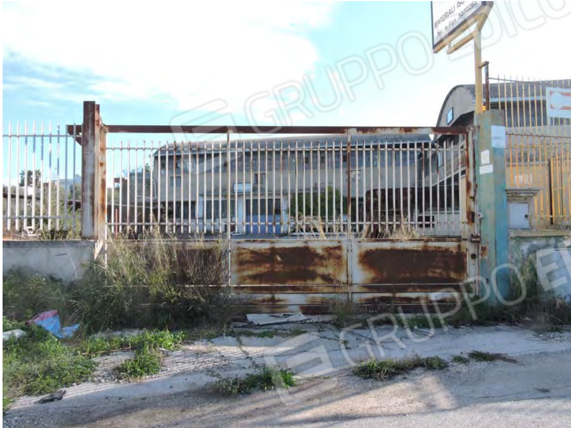
Accesso – strada Fondo Capillo del Campo
