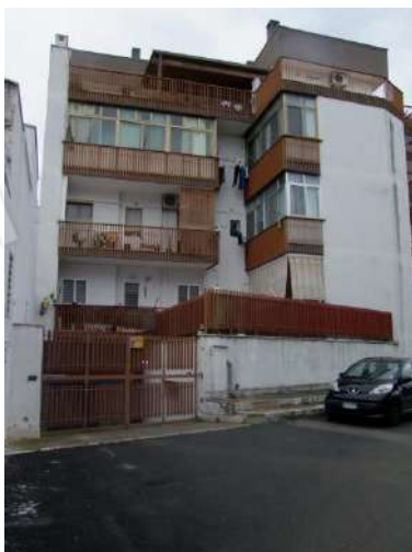
Foto 3 e 4 – Viste del prospetto laterale su via G. Armellini
