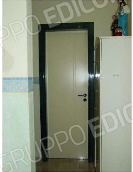
Foto 32 - Particolare infisso interno
