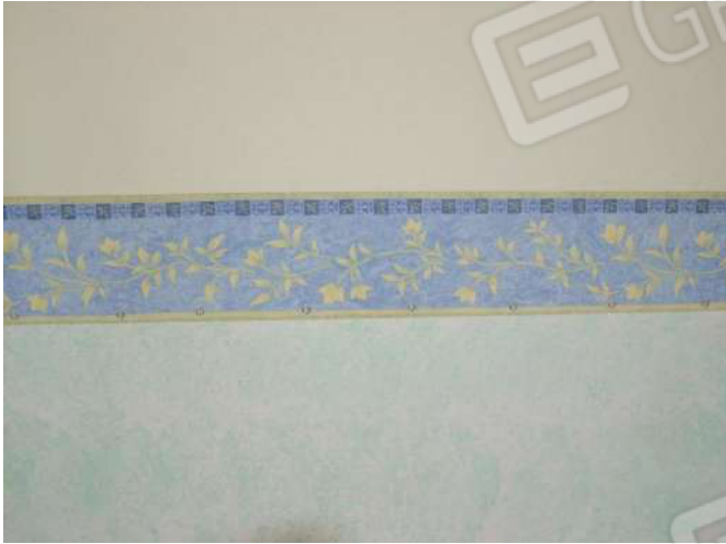
Foto 31 - Particolare parete dell'ambiente L1
