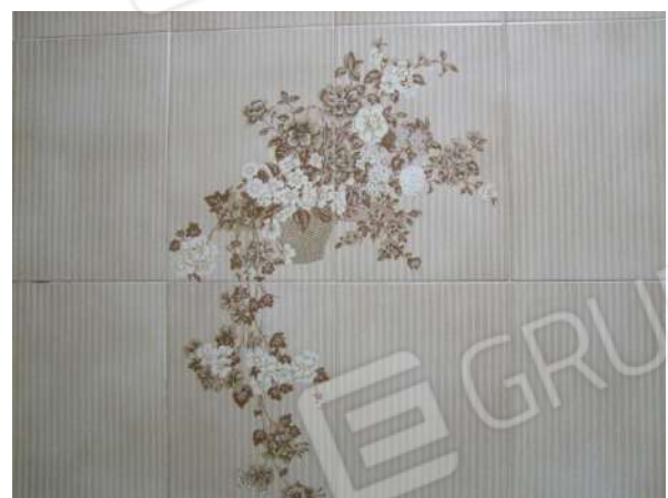
Foto 30 - Particolare rivestimento bagno
