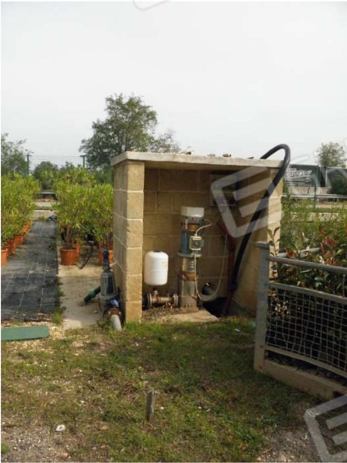
**FOTO NN. 156-157: IMPIANTO SOLLEVAMENTO IDRICO A SERVIZIO DELLA CISTERNA RISERVA IDRICA INTERRATA PRINCIPALE (FOTO IN ALTO); IMBOCCO CISTERNA IDRICA (FOTO IN BASSO).**
