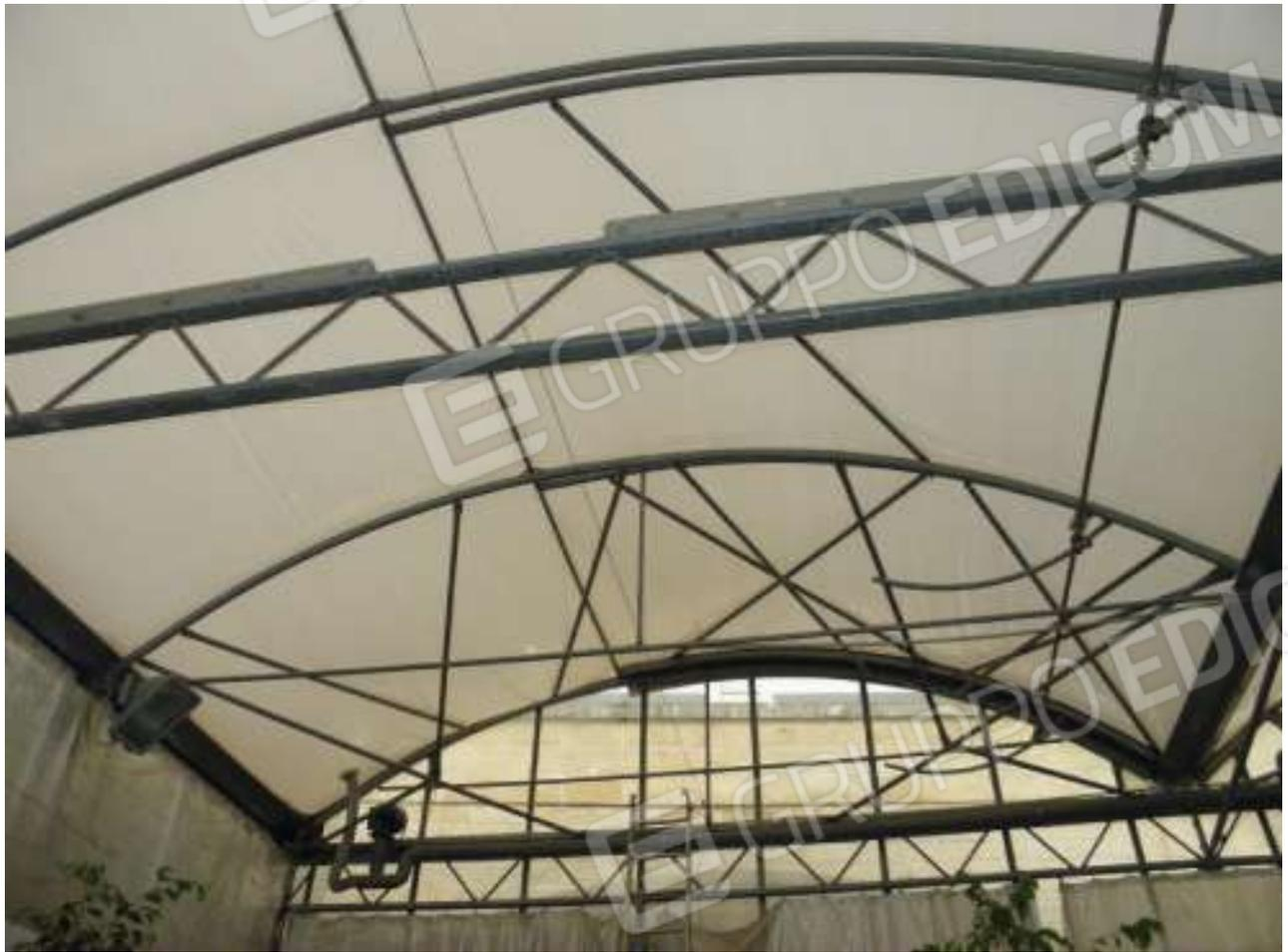
**FOTO NN. 142-143: PARTICOLARE DELLA STRUTTURA DI COPERTURA DELLA SERRA-GARDEN (FOTO IN ALTO); PARTICOLARE DEL MONTANTE STRUTTURALE IN ACCIAIO E DELLA SISTEMA IN ANTICORODAL E VETRO DI CHIUSURA (FOTO IN BASSO).**
