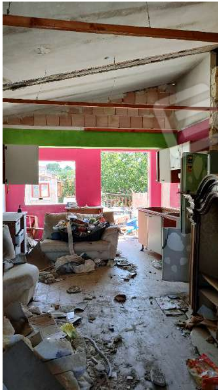
Foto 16: Vista della porzione di vano interessata da ampliamento volumetrico
