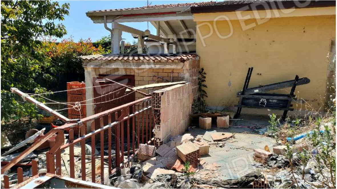
Foto 13: Vista del vano tecnico dalla veranda retrostante l'abitazione
