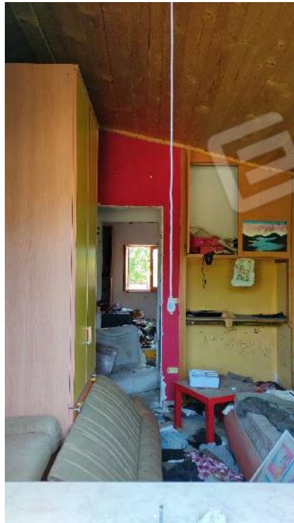
Foto 18: Vista ultimo vano a destra percorrendo il disimpegno
