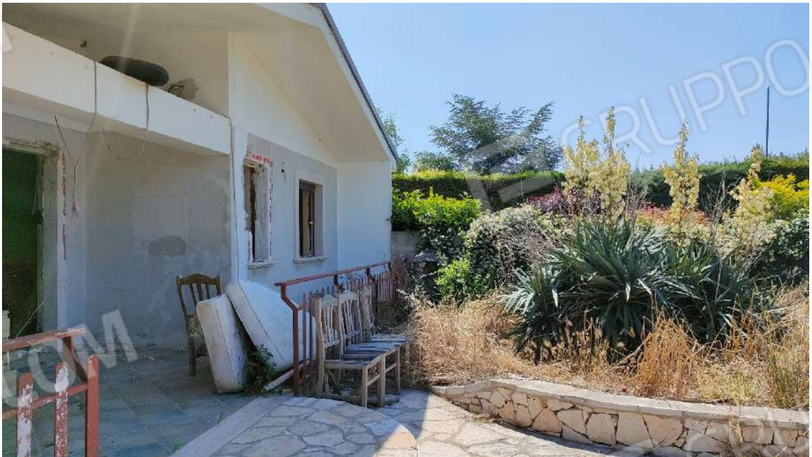
Foto 4: Vista area antistante l'abitazione
