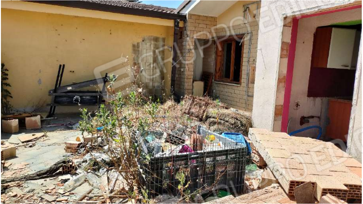
Foto 9: Vista veranda retrostante l'abitazione
