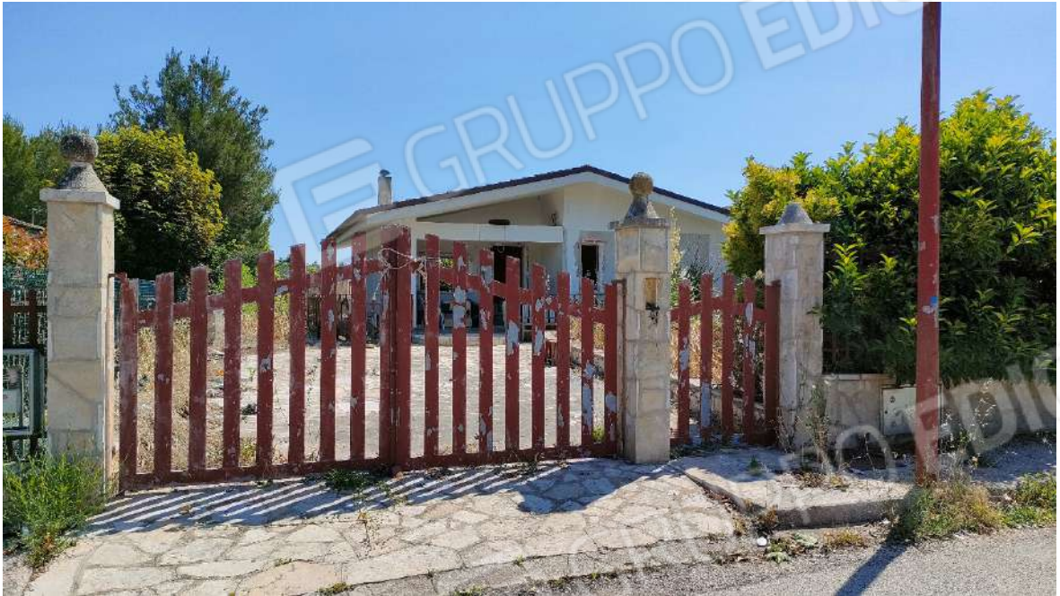
Foto 1: Vista dell'ingresso al lotto unico di vendita dalla strada condominiale interna al "Residence Lago battaglia"
