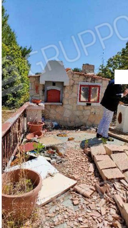
Foto 15: Vista del forno in muratura
