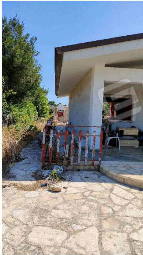
Foto 6: Vista area esterna laterale
