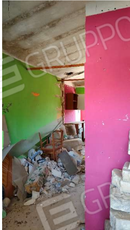
Foto 19: Vista vano destinato a cucina/soggiorno
