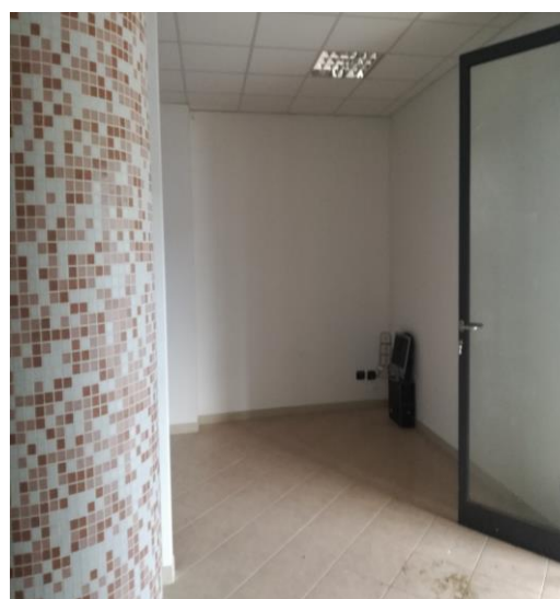
FOTO n. 6: Interni Locale Ufficio
