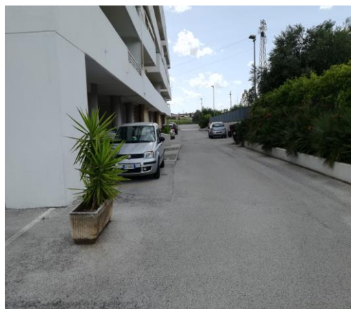
FOTO n. 15: Cortile Condominiale di accesso alla rampa
