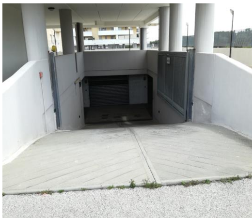
FOTO n. 16: Rampa lato accesso
