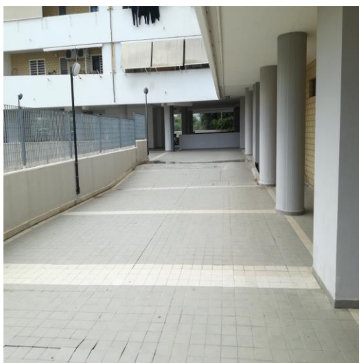
FOTO n. 11: Prospetto su Cortile Interno
