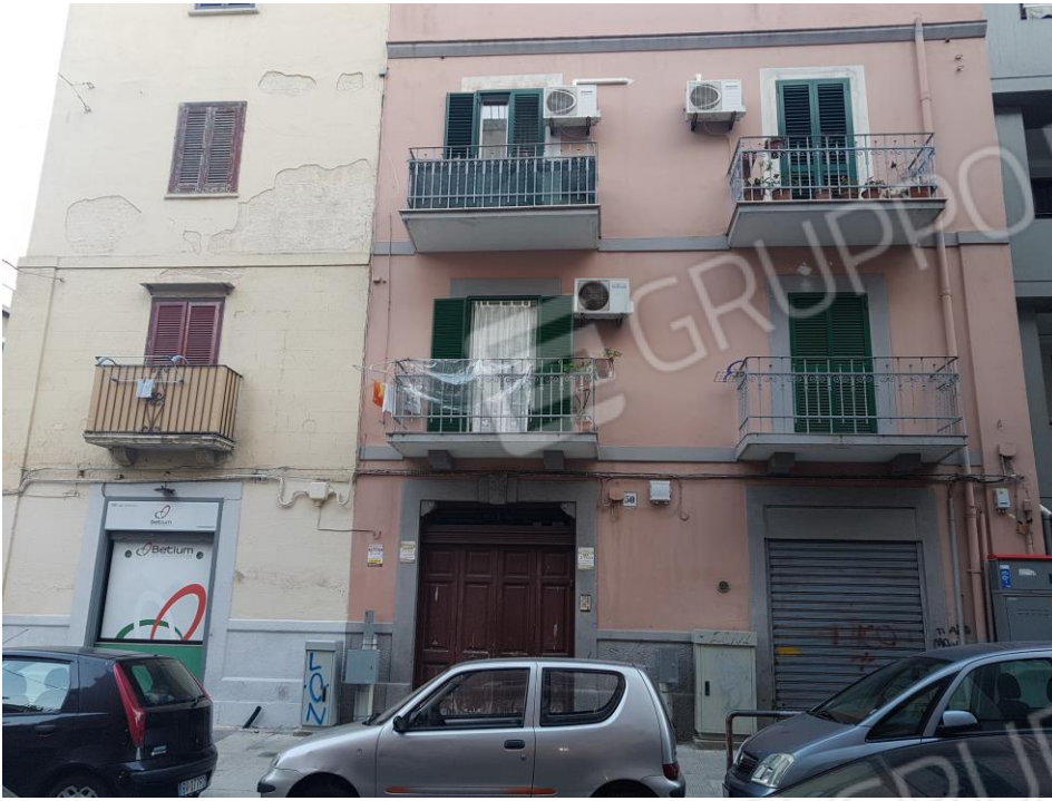
Foto 1 – Prospetto Esterno su Via Indipendenza
