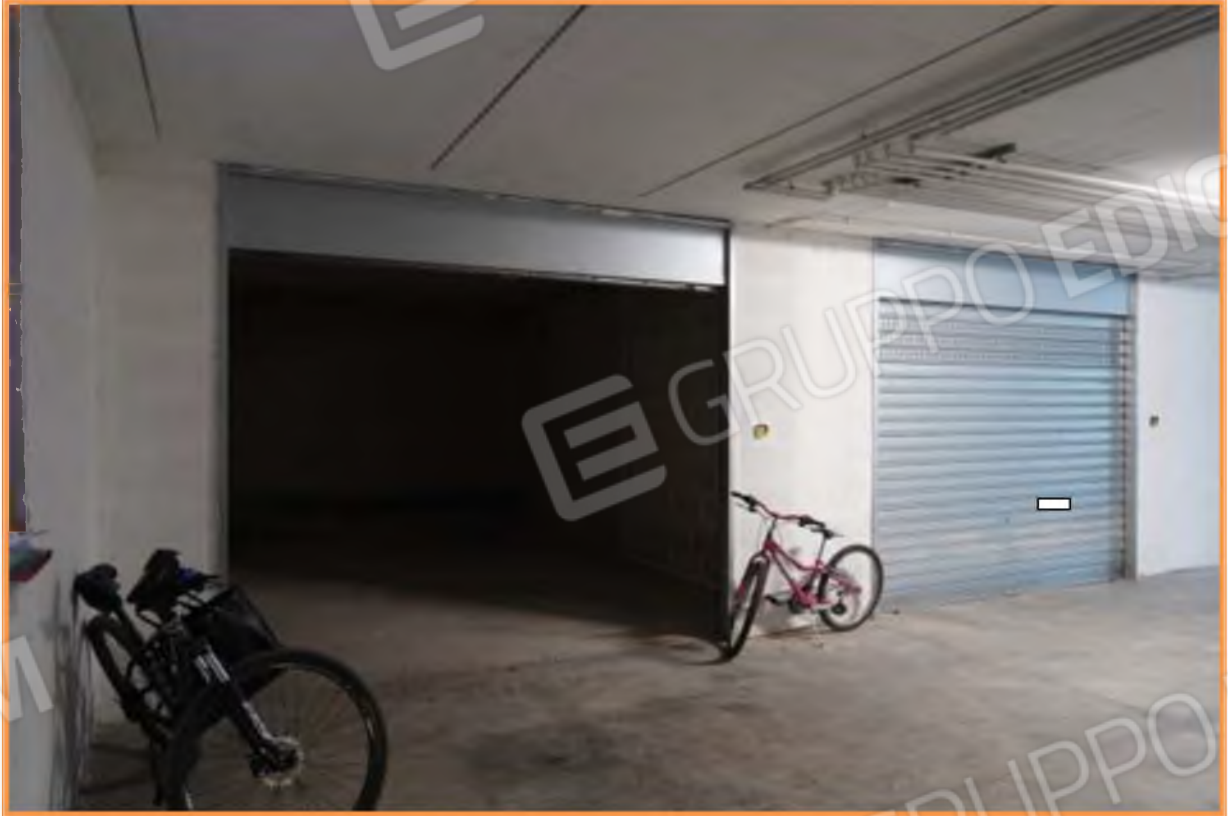
FOTO n° 9. Piano interrato. Primo box a destra di chi entra nel corridoio distributore. Vista verso la direzione sud. Identificazione catastale: [REDACTED]
