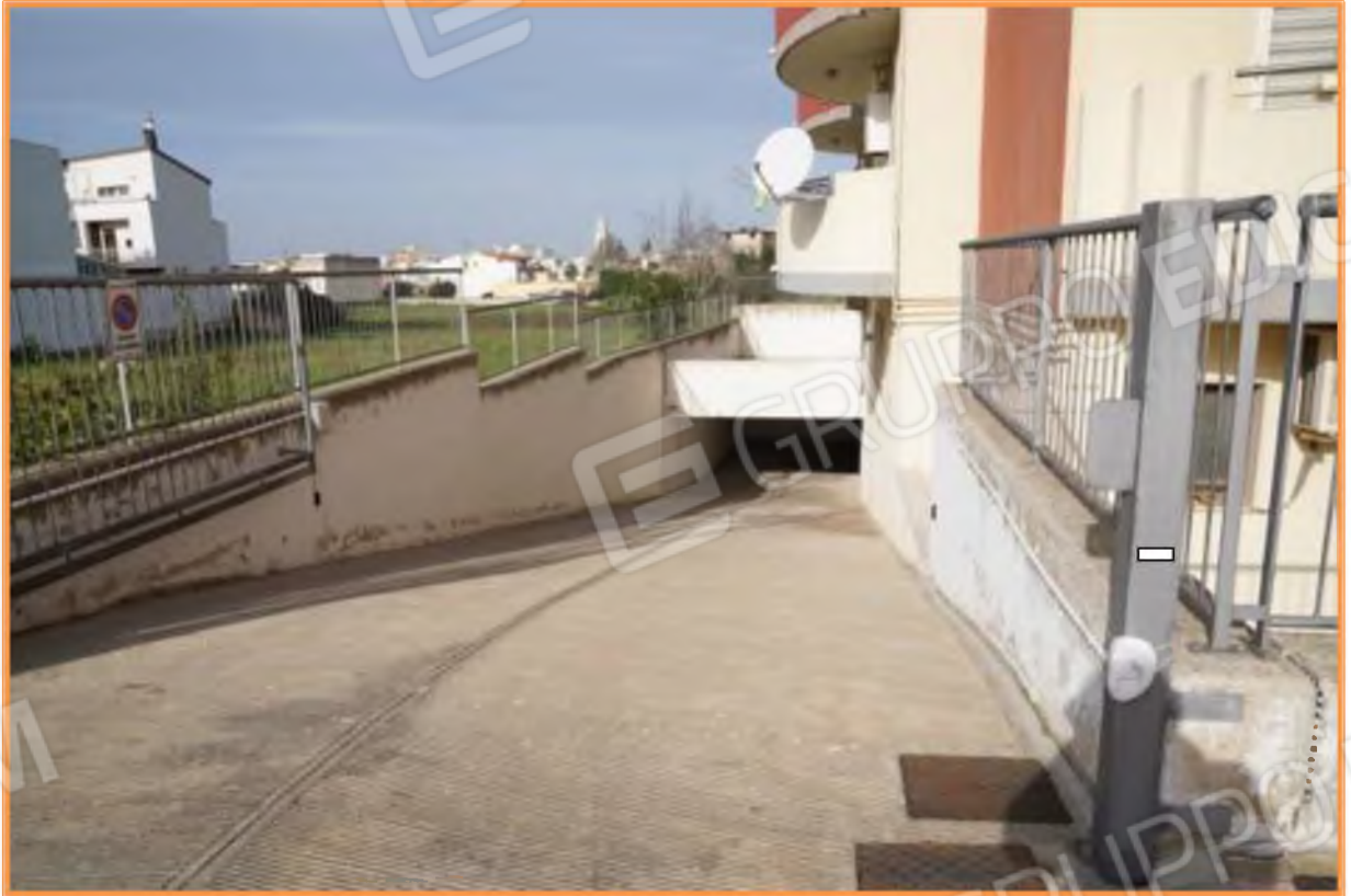
FOTO n° 4. Come foto n° 3.
