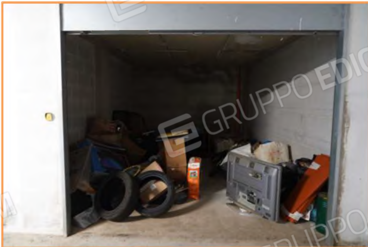
FOTO n° 13. Piano interrato. Ultimo box a sinistra di chi entra nel corridoio distributore. Vista verso la direzione nord. Identificazione catastale: [REDACTED]
