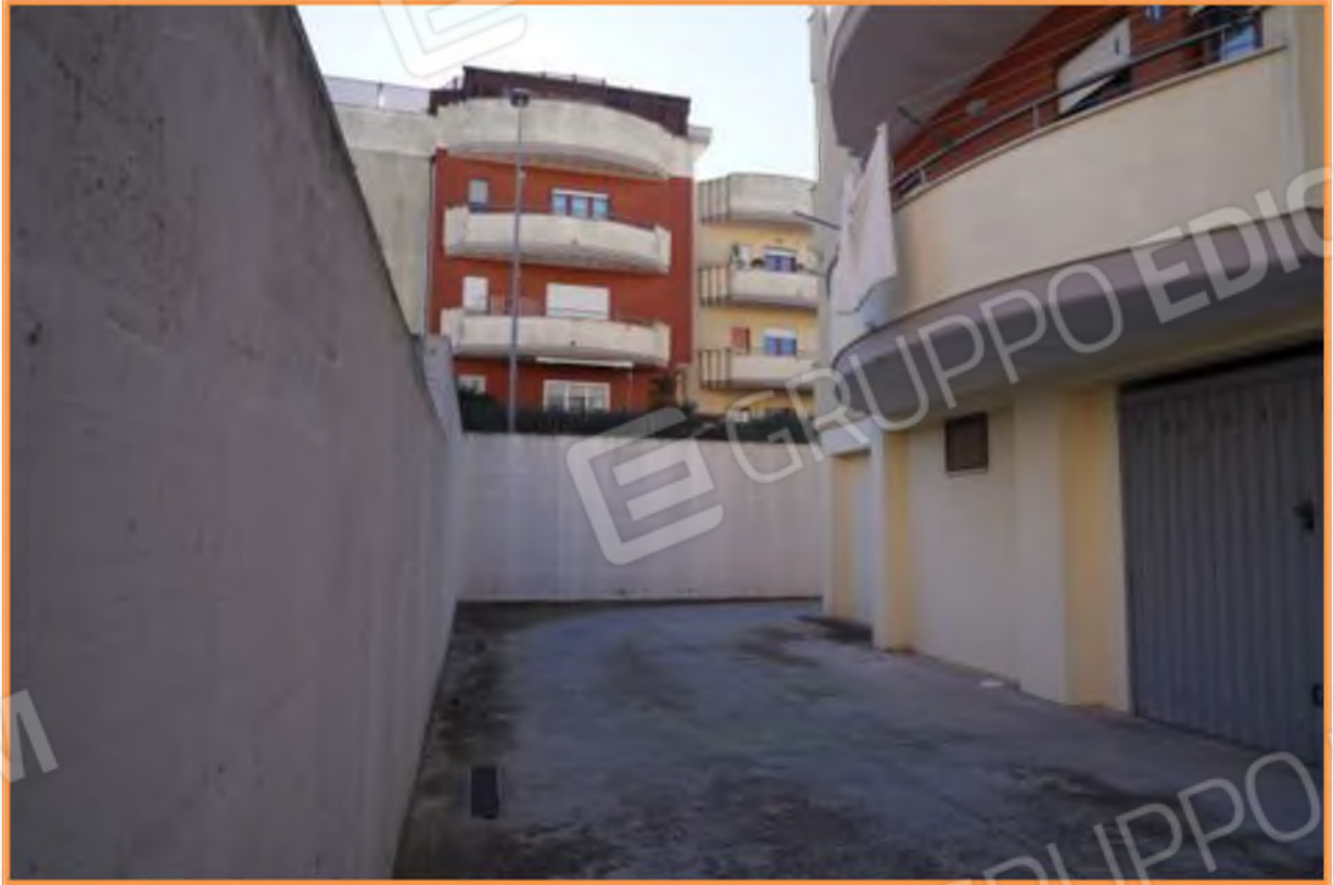
FOTO n° 3. Vista verso la direzione sud dell'area scoperta a livello seminterrato del lotto in cui è sito l'edificio con accesso dai [REDACTED]. L'area scoperta, dopo la discesa dalla rampa, circonda da tre parti l'edificio e distribuisce ai box.
