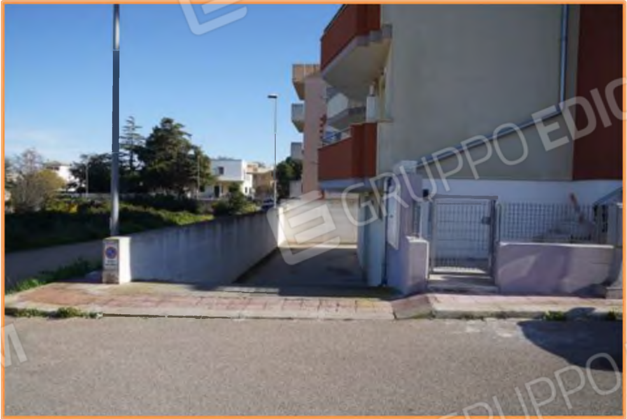
FOTO n° 2. [REDACTED] Vista verso la direzione est della rampa di accesso all'area scoperta seminterrata del lotto in cui è sito l'edificio con accesso dai [REDACTED]. La rampa è contigua al prospetto nord dell'edificio.
