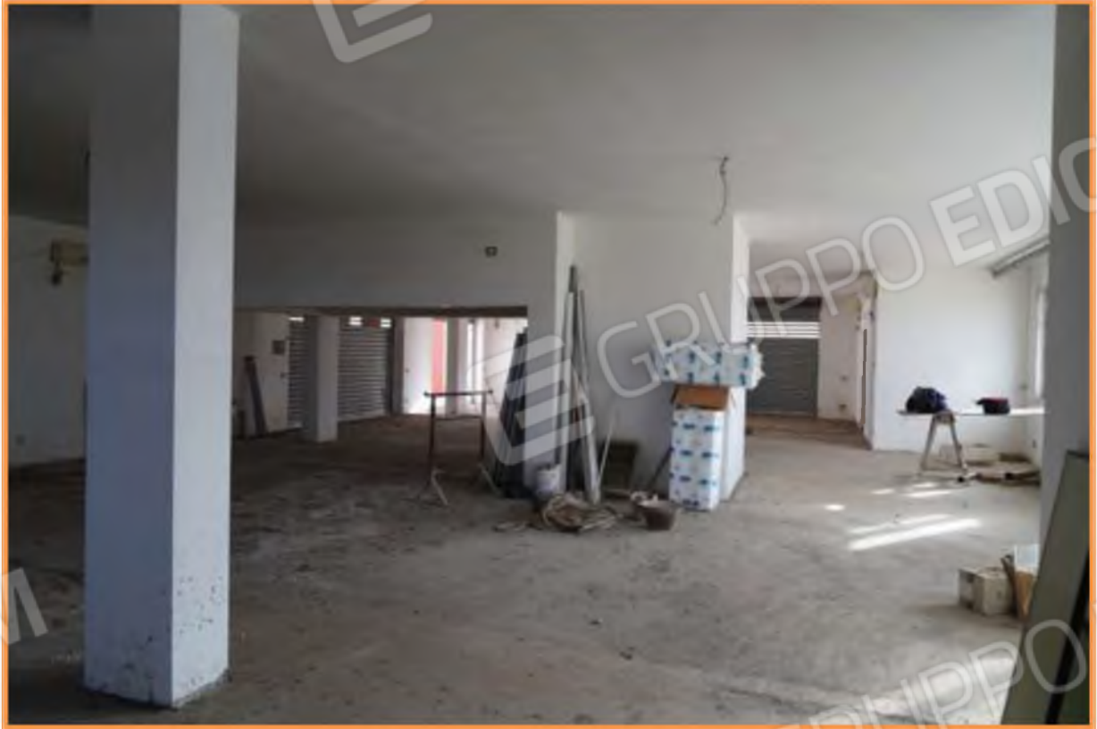
FOTO n° 15. Come foto n° 14, vista nella direzione opposta, verso sud. Vista verso i servizi igienici-blocco n° 1.
