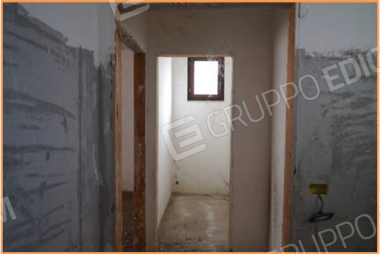
FOTO n° 17. Servizi igienici-blocco n° 1. Vista del disimpegno e del w.c. a sud.
