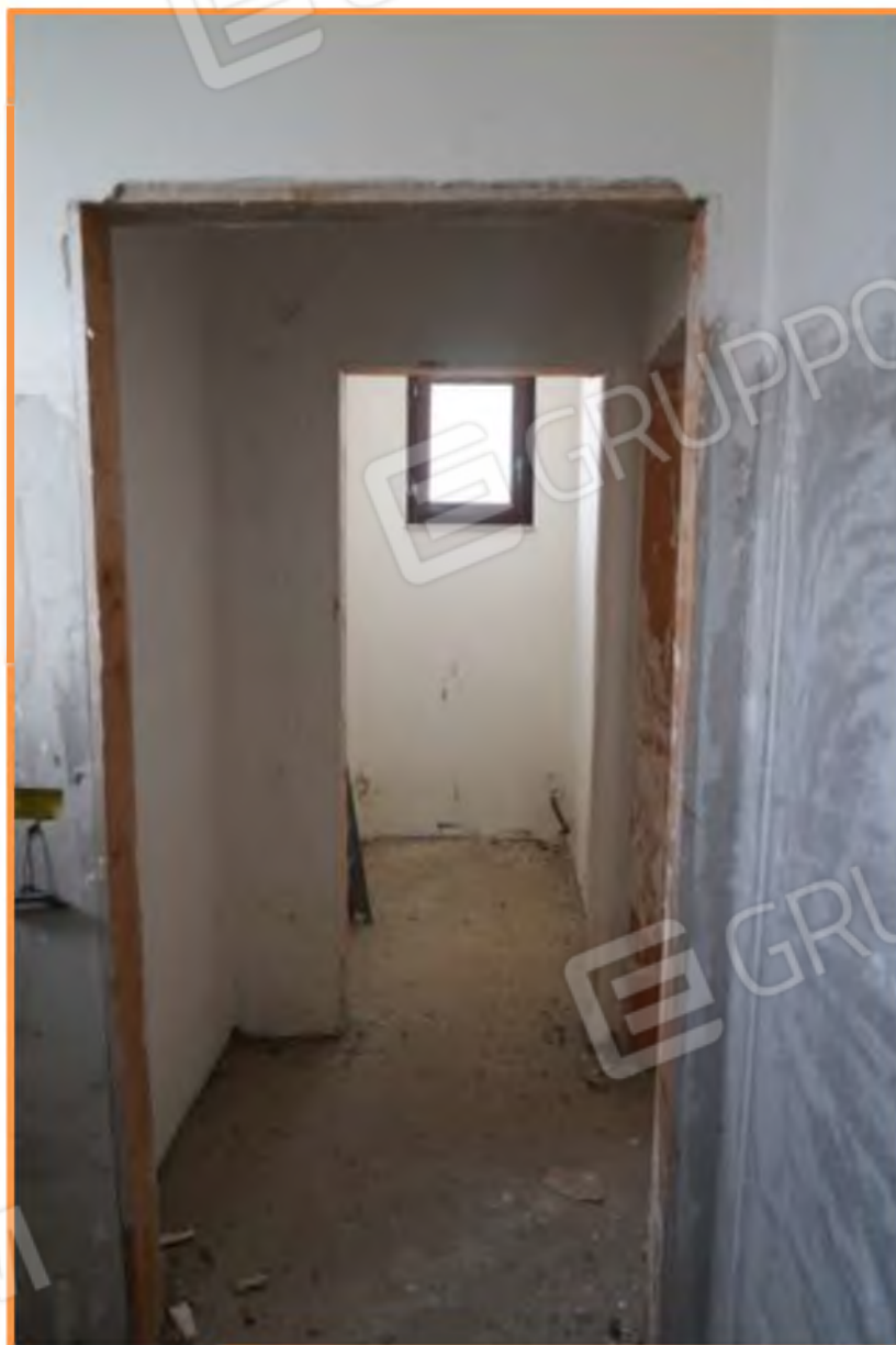
FOTO n° 22. Servizi igienici-blocco n° 2. Vista del disimpegno e del w.c. a nord.
